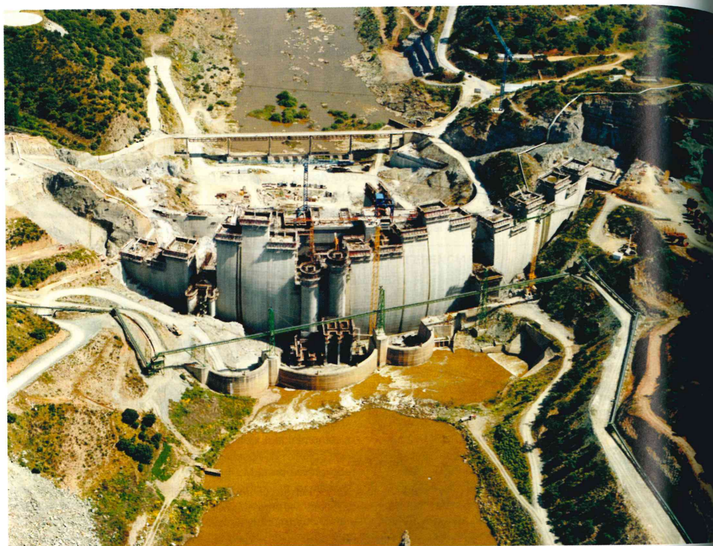
Vista general de las obras en junio de 2000.
