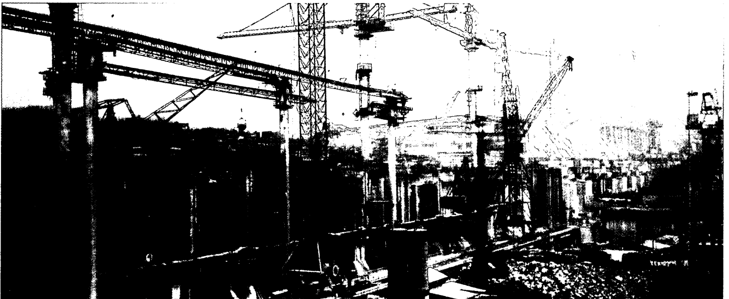
Foto 3: Vista de la presa en construcción desde aguas arriba. Por la derecha fluye el Yangtze en la segunda fase de su desvío; se construye en el recinto central al amparo de ataguías de 72 metros de altura, la central izquierda de pie de presa y la zona de aliviaderos; a la izquierda se construyen las estructuras de navegación. Abajo, foto 4: Cuerpo de presa en construcción (septiembre 2000)
