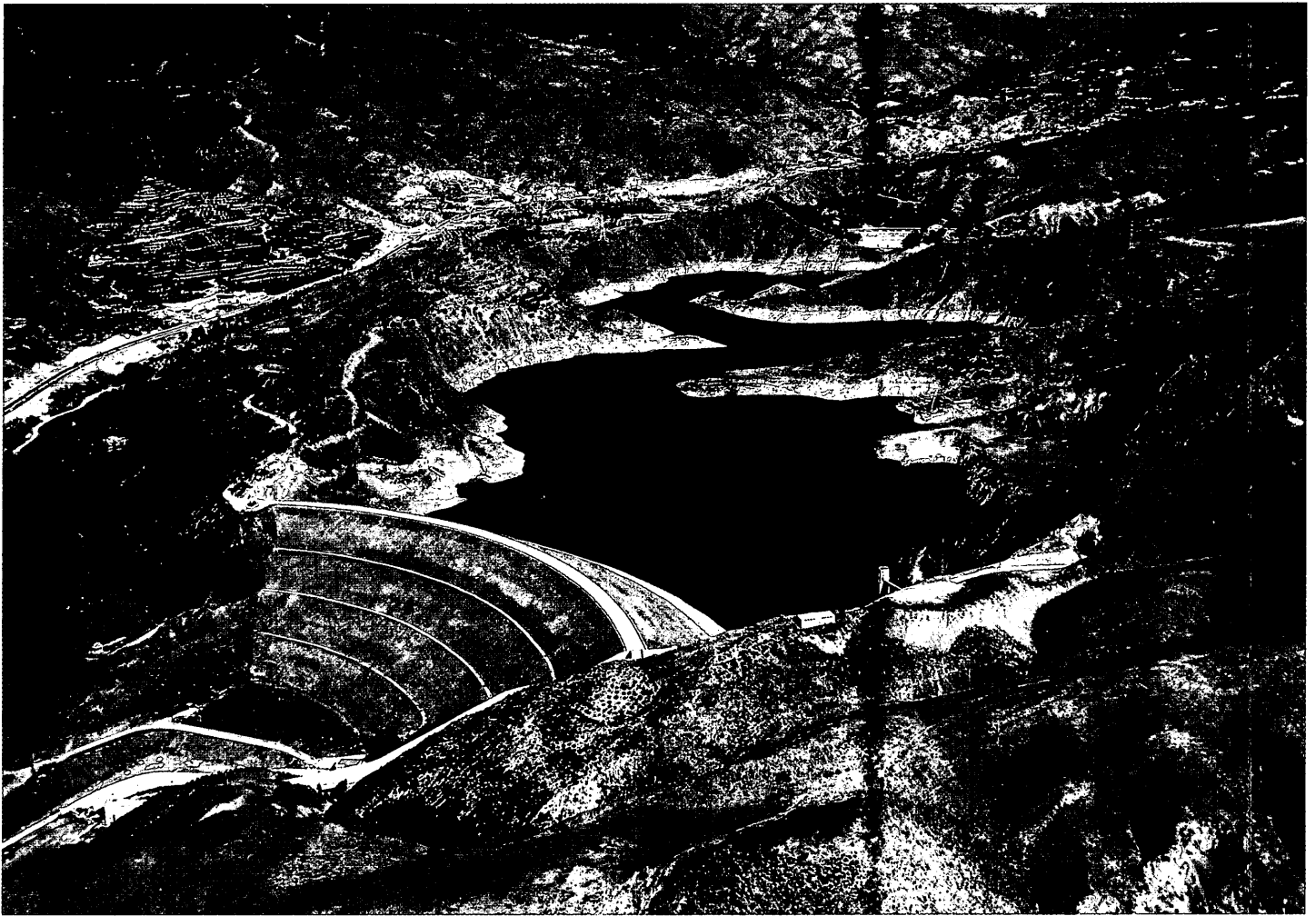
Presa de El Limonero. Objetivo: Protección contra las inundaciones.
