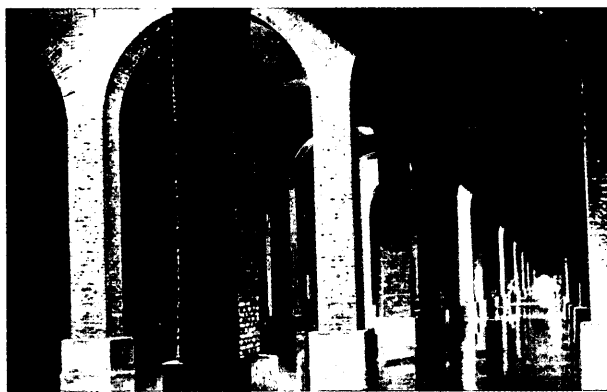
Tercer depósito durante su construcción. A la dcha. el tercer depósito en uso. (Fritz von Emperger. Revista de Obras Públicas, 1907).
