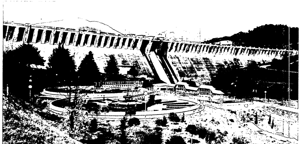
Presa y estación de tratamiento de Navacerrada.
