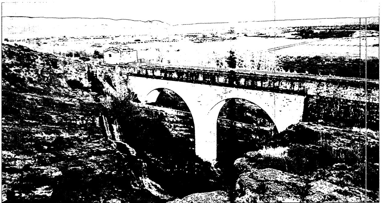
Canal de La Parra, acueducto de Las Cuevas.
