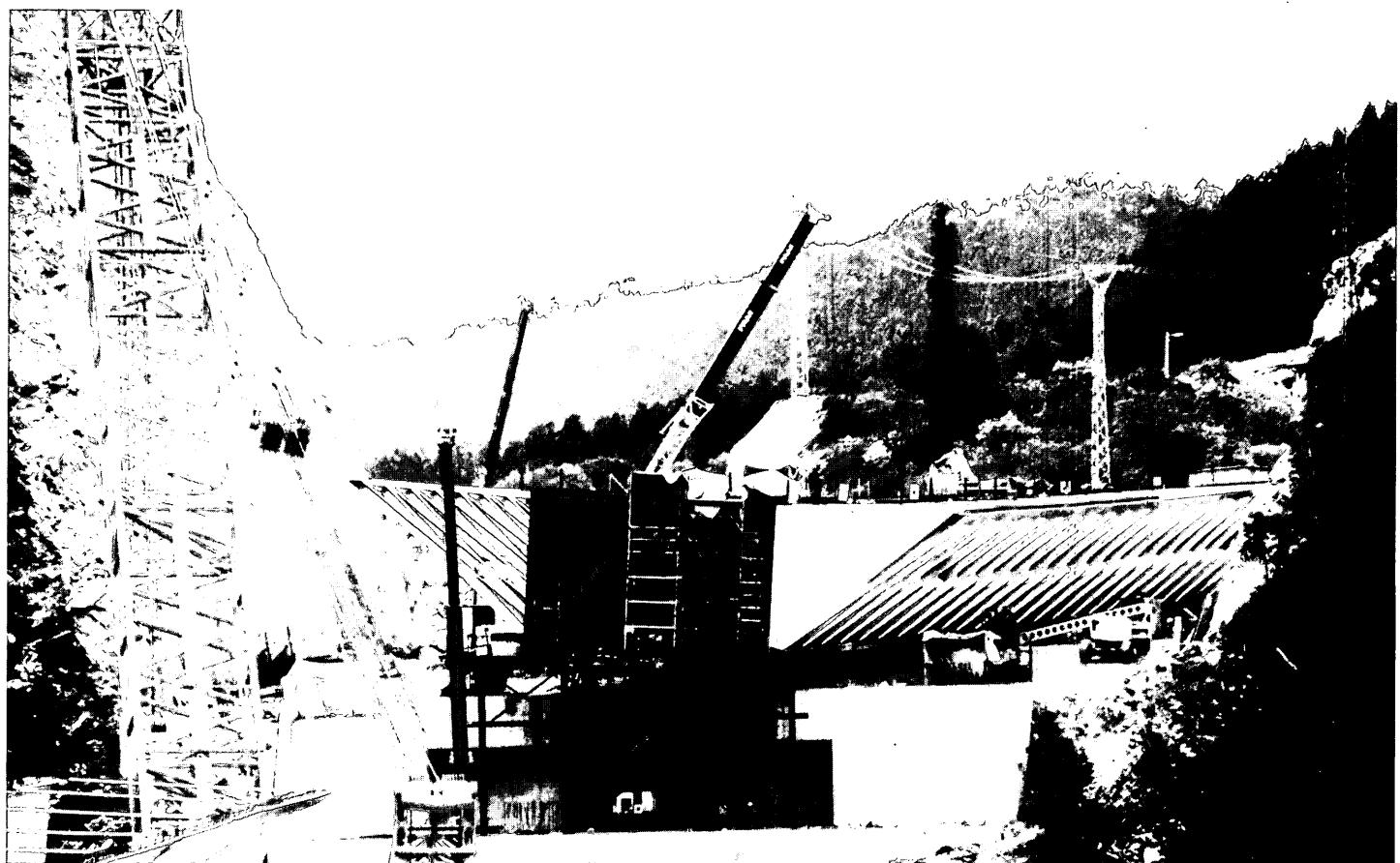
5. Desapeo de la estructura metálica a excepción de la torre de apeo provisional situada al final del tramo 8
