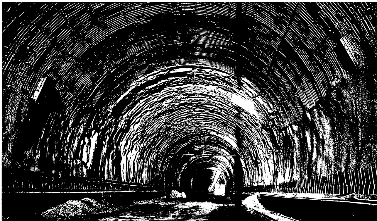
Túnel en los tramos Madrid- Zaragoza y Zaragoza- Lérida del Ave Madrid- Barcelona- Frontera francesa.
