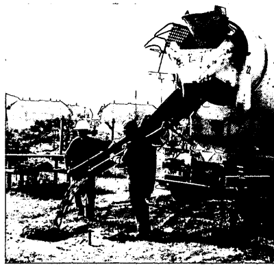
Relleno con mortero en taladro en M-40, relleno de taladros en las Presillas y ejecución de taladros de comprobación en Avda. Joaquín Vilumbrales.
