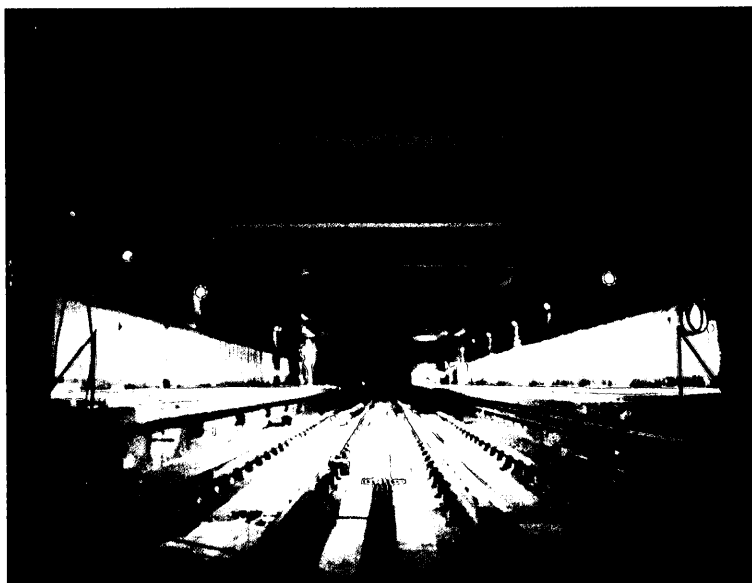
Figura 16. Estación de Conservatorio.
