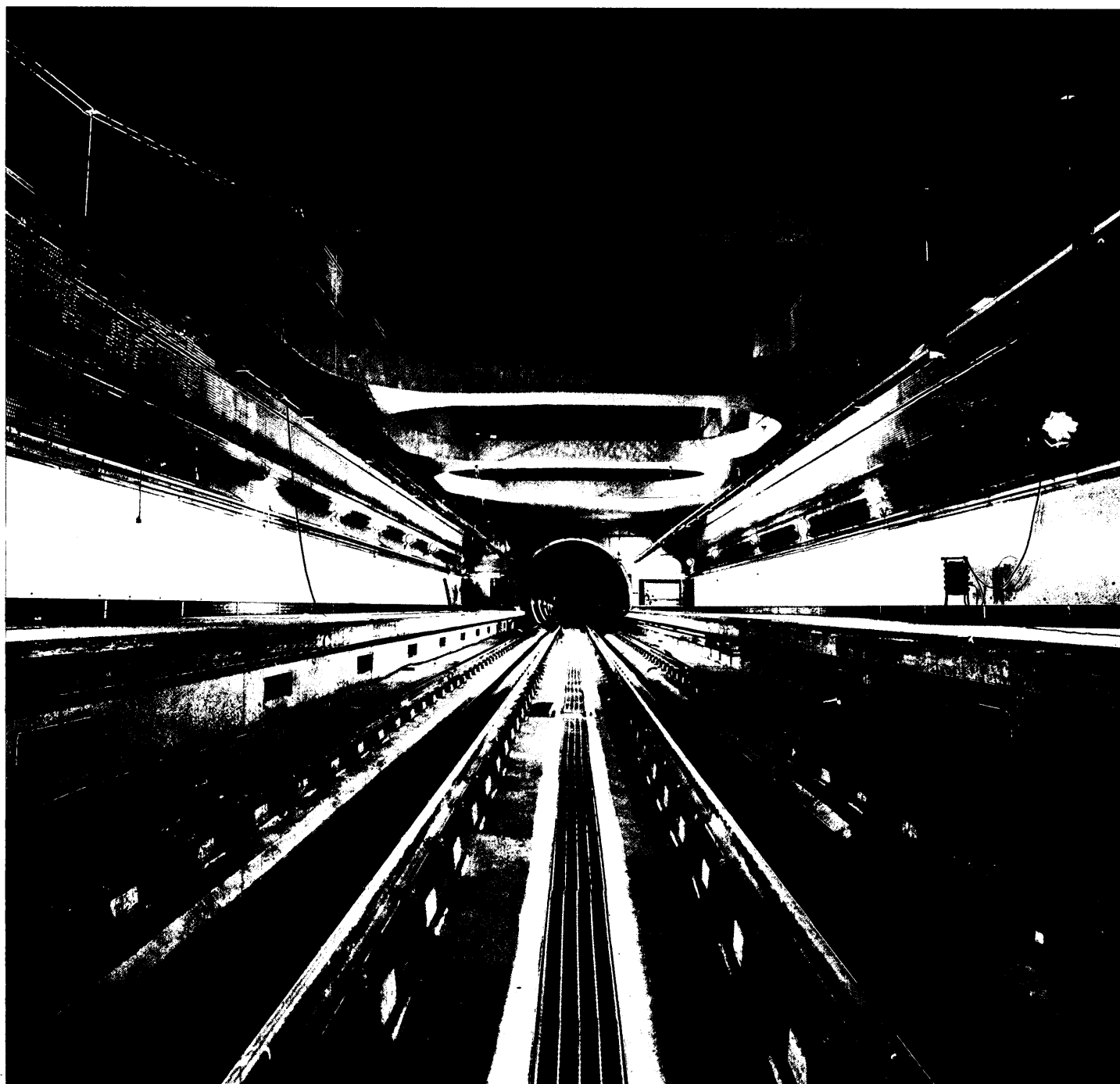
Figura 10. Estación Fuenlabrada Central.
