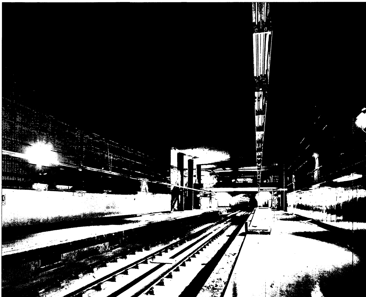
Figura 6. Estación Arroyo Culebro.
