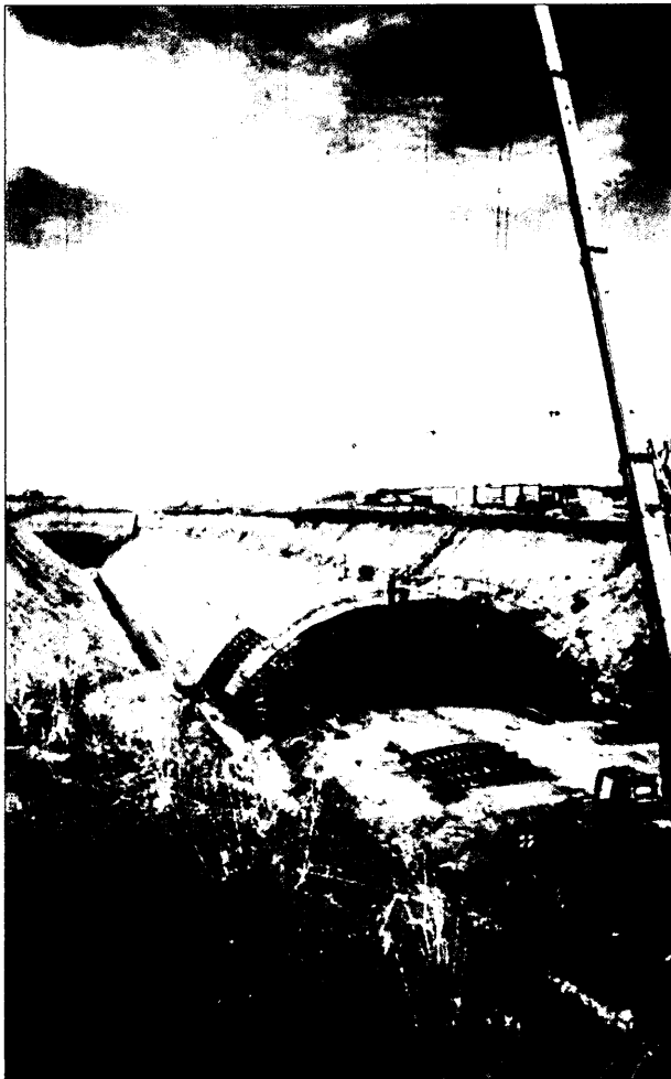
Figuras 20 y 21. Bóveda estación in situ y bóveda estación carro de encofrado.
