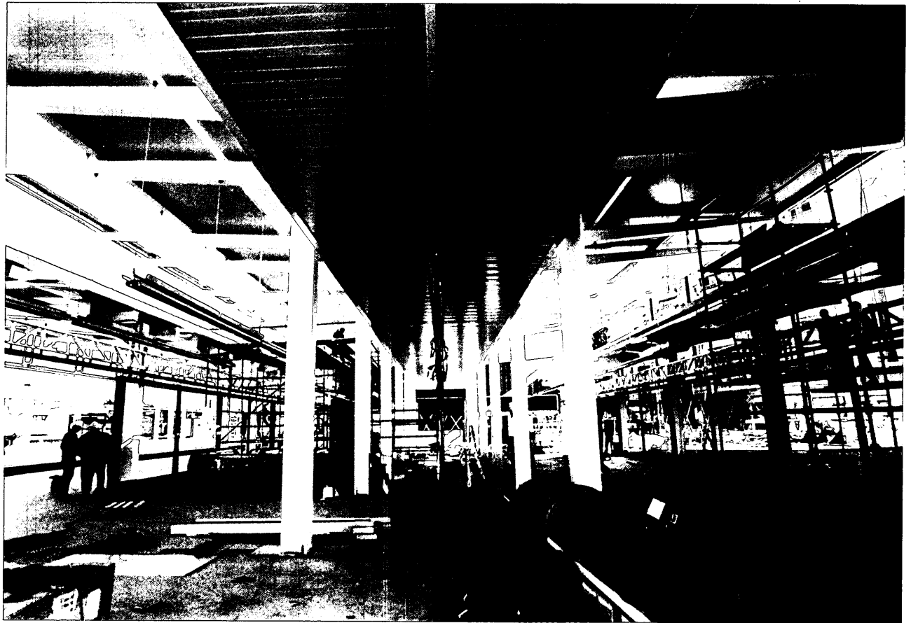
Intercambiador de Cercanías. Vestíbulo principal.
