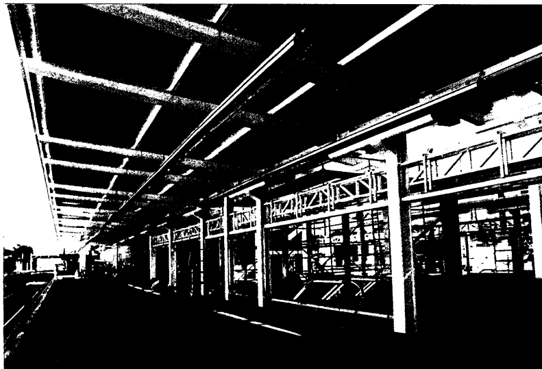
Nueva Estación de Cercanías en Intercambiador con METROSUR.
