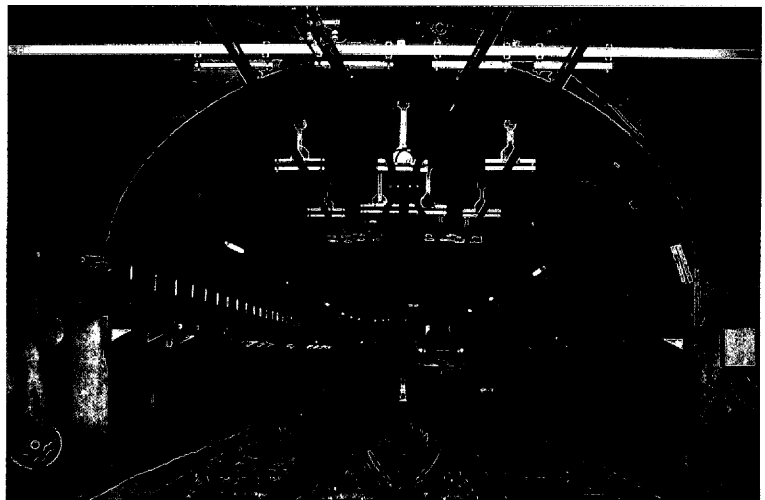
Túnel de unión con la Línea 10.
