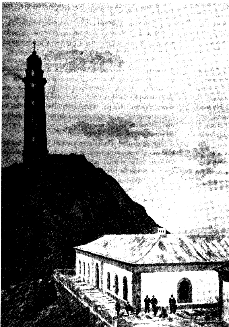
Faro de cabo Villano, de luz eléctrica (Coruña). (ROP 1897).
