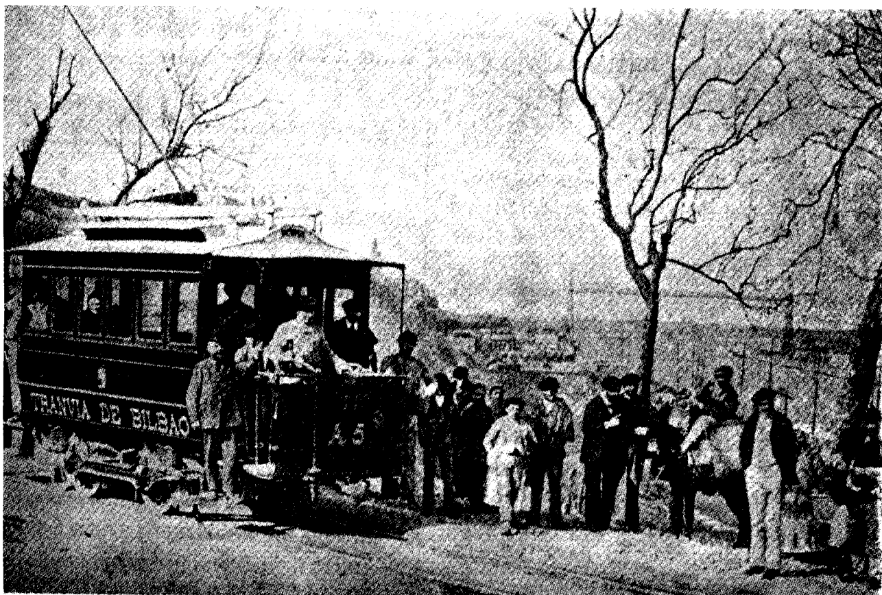
Tranvía eléctrico de Bilbao. (ROP 1897).
