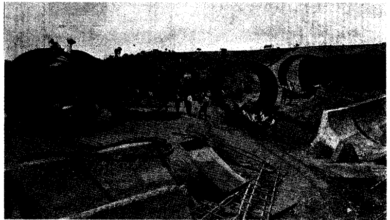
Cambio del Ribadona y transporte de un tubo a él.
