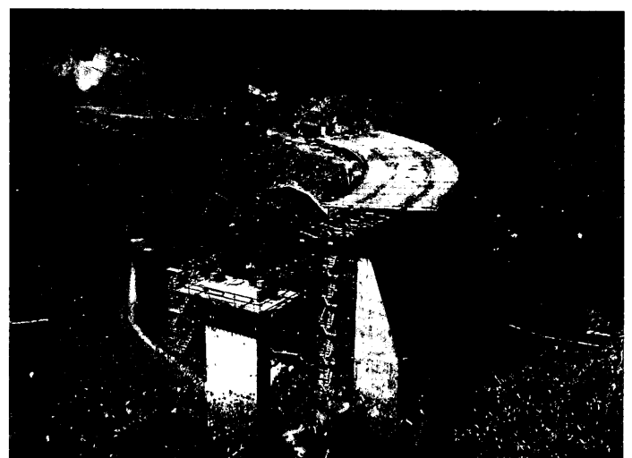
A la izquierda, figura 35. Lanzamiento del tablero (Viga cajón metálica más prelasas de hormigón). En el extremo frontal existe una zona libre de prelasas. A la derecha, figura 36. Aspecto del tablero durante una de las fases de lanzamiento.
