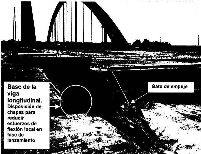
Figura 23. Tablero montado en tierra firme, dispuesto para iniciar el lanzamiento. Arriba a la derecha, figura 24. Pilas provisionales. Debajo, figura 25. Gatos destinados a recuperar la flecha elástica del conjunto, antes de alcanzar cada uno de los apoyos.
