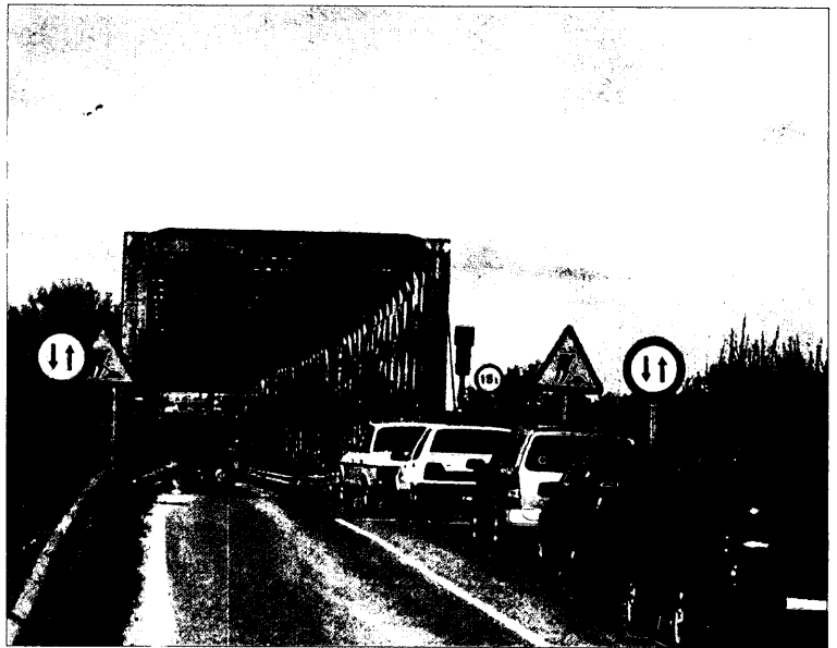
Figura 17. Puente antiguo existente. Calzada.
