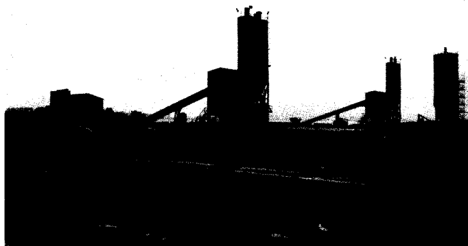
Plantas de hormigón.
