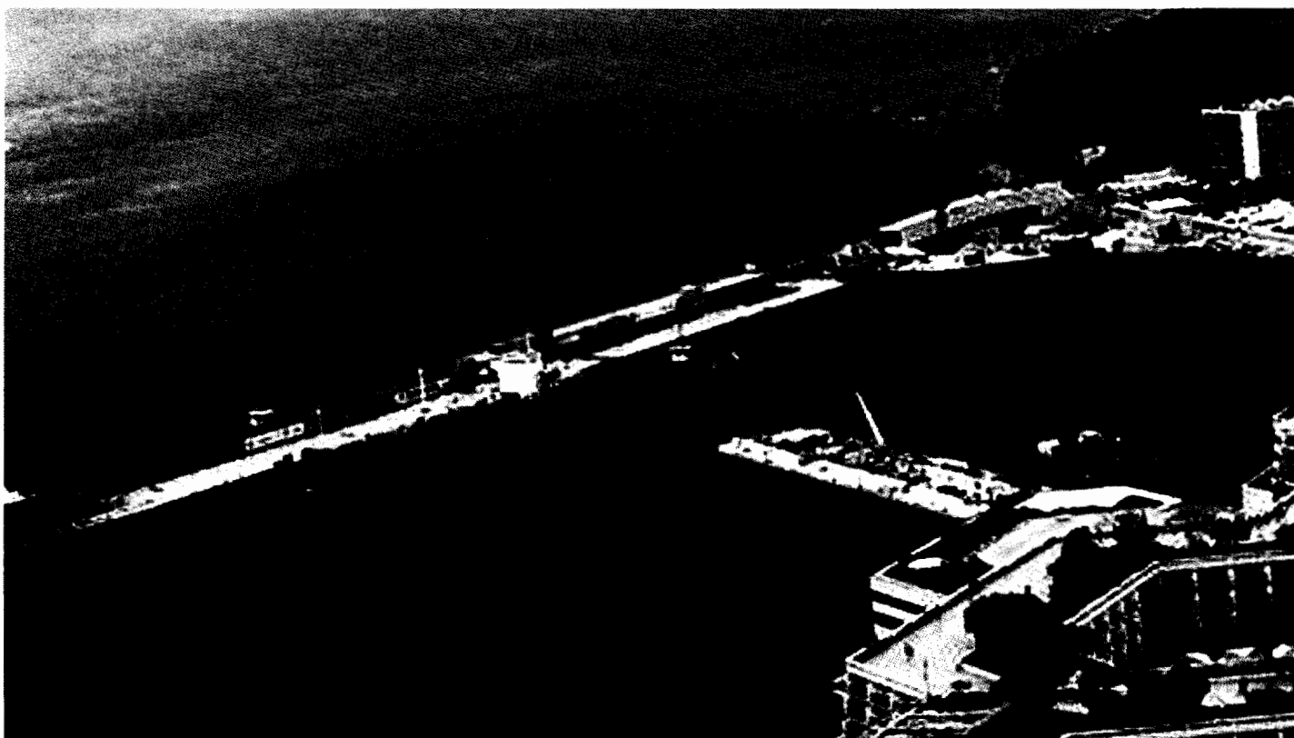
Lastrado del dique en Mónaco antes de la instalación.
