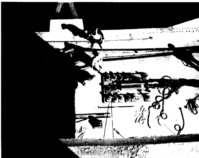
Instalación sobre el dique de la línea de remolque.
