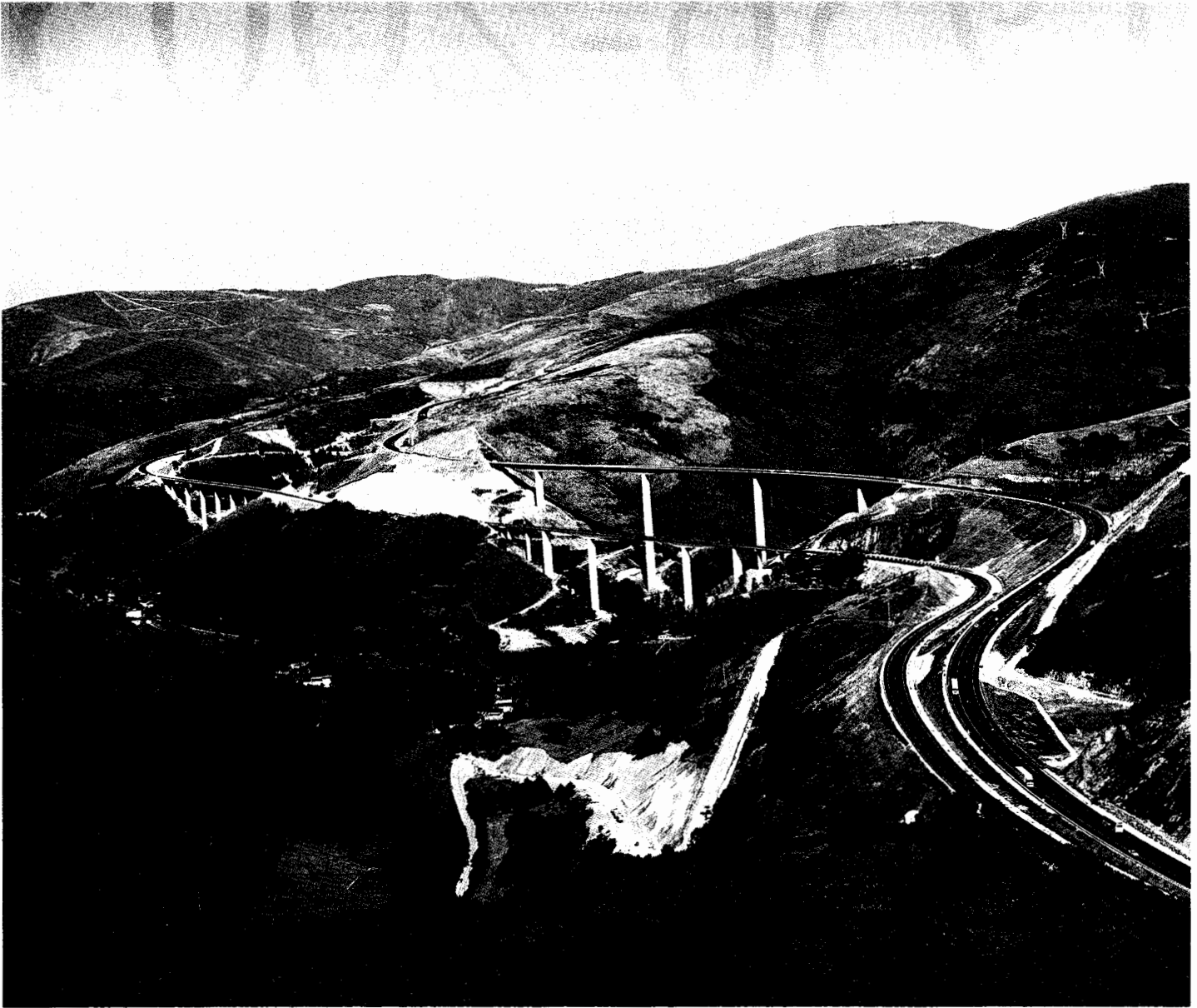
Viaductos de Samprón, Ruitelán y Herrerías.
