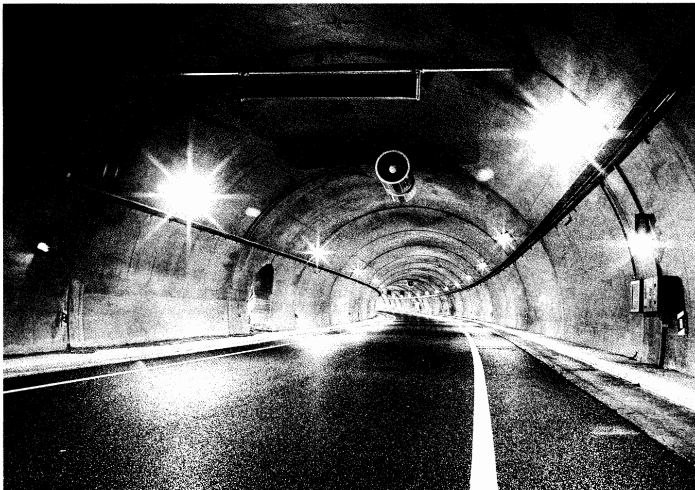
Interior del túnel de Doncos.
