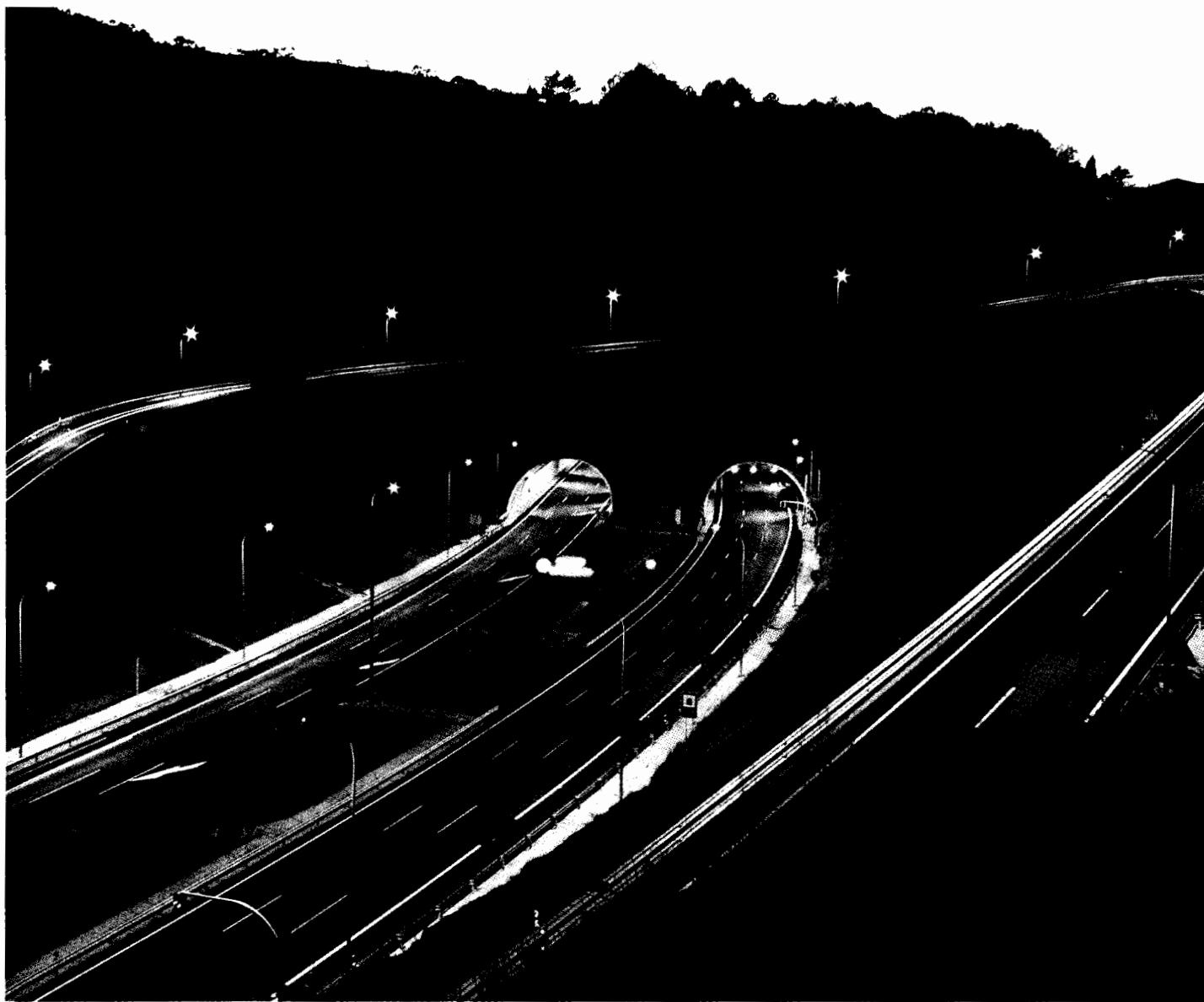
Túneles de Piedrafita. Boca sur y semienlace sur de Pedrafita do Cebreiro.
