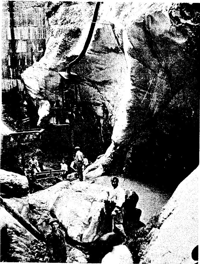
Grandes "marmitas de gigante" en la cimentación de la presa de La Peña (Río Gállego), hacia 1910.
