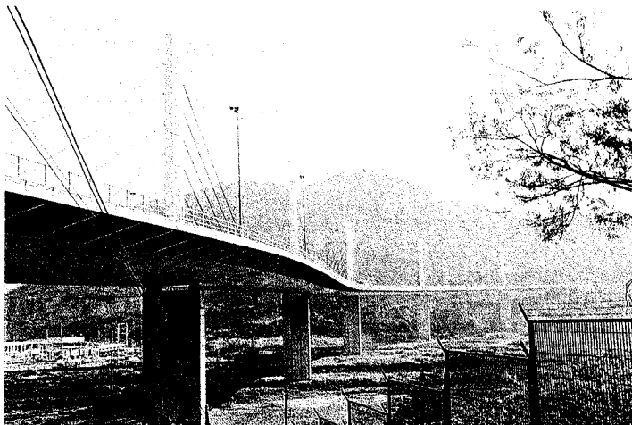
Fig. 5. Viaducto de la Arena en Somorrostro, Bilbao, de Juan José Arenas (1992).
