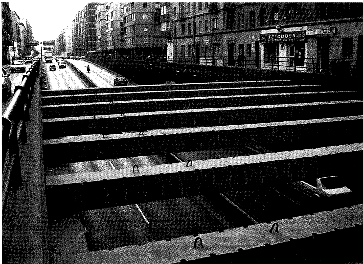
Foto 1. Boca Este: Detalle de las Vigas/ Photograph 1. East mouth. Details of cross beams.
