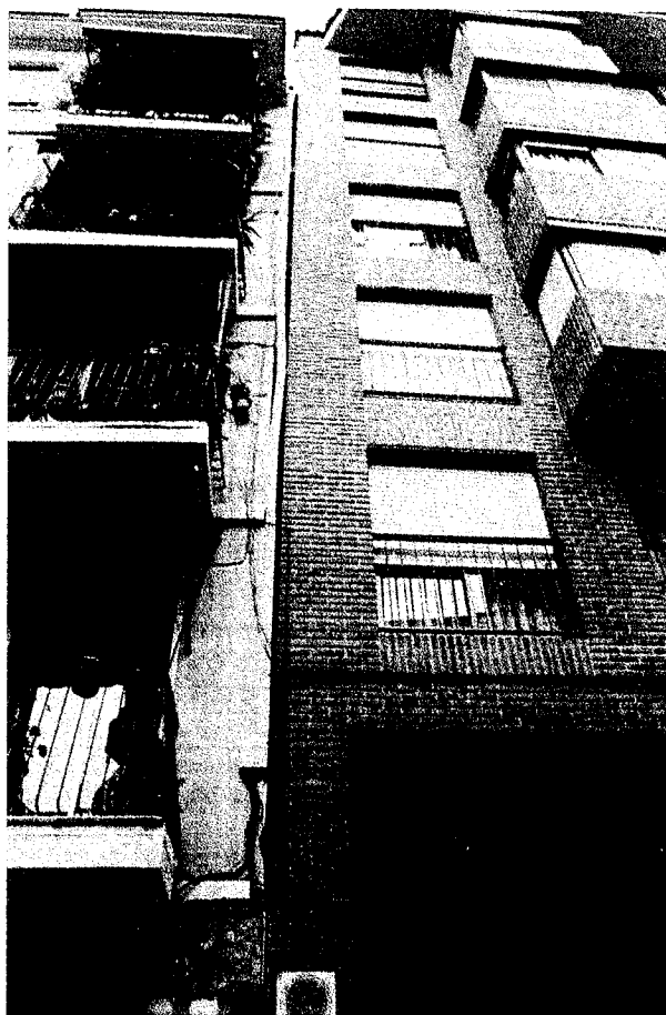
Fig. 3. Apertura de la junta entre dos edificios, creciente según la altura.
