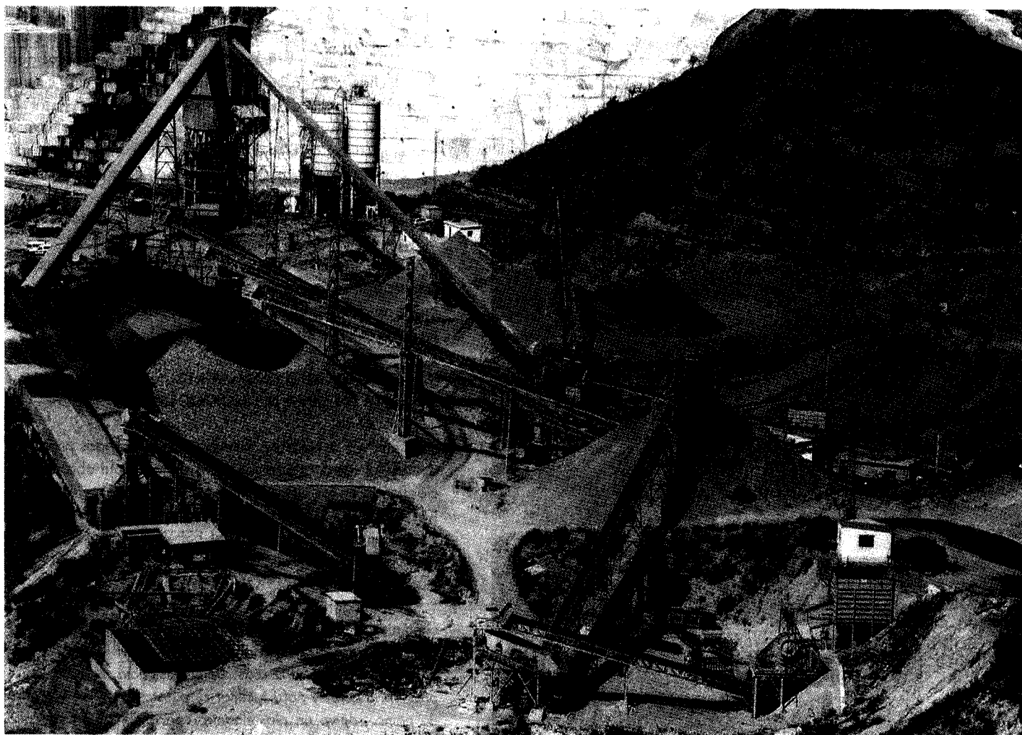
Vista general de instalaciones para fabricación de áridos y hormigón.
