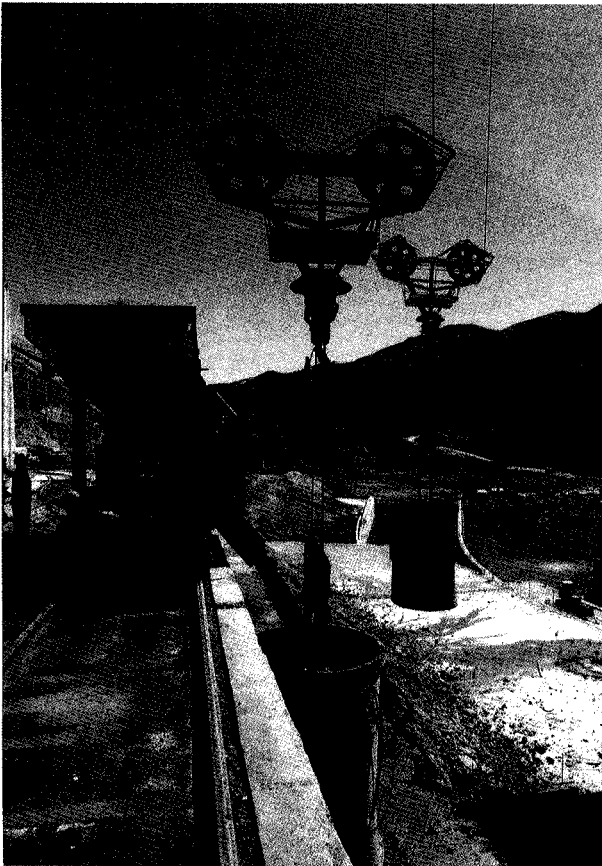
Carga de cazos con hormigón, silobuses en muelle cazos.
