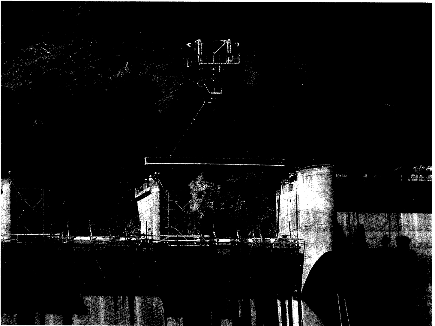
Colocación de las vigas del puente sobre el aliviadero con blondin.
