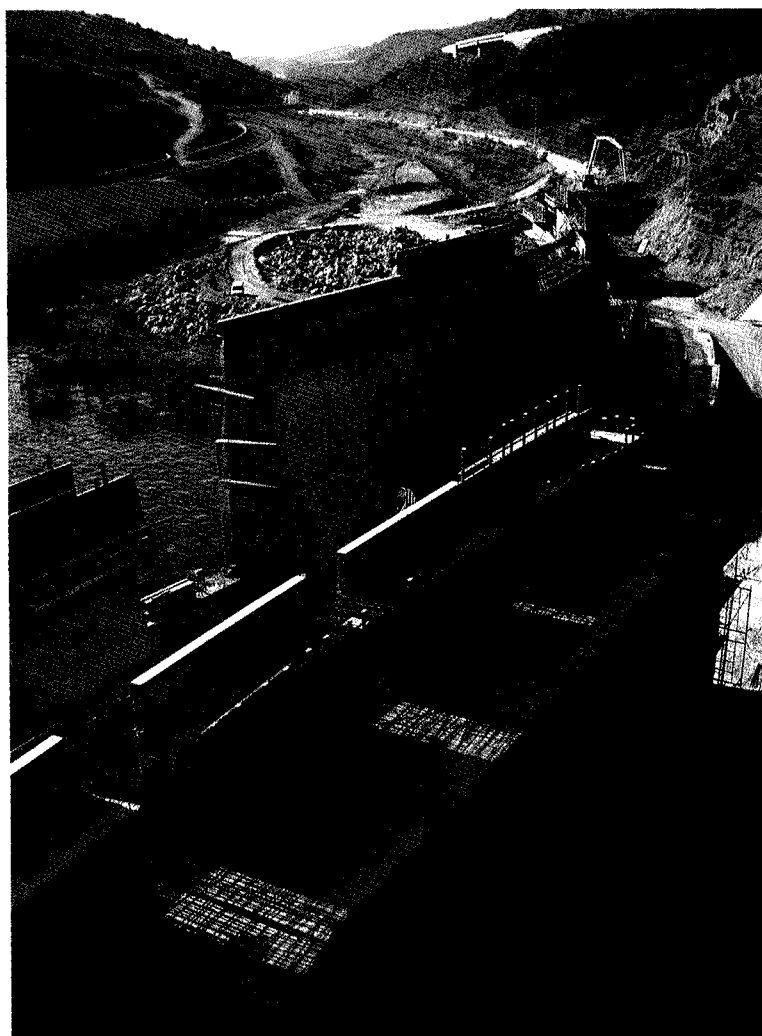
Vista del muro cajero derecho en construcción. Hueco para futura central hidroeléctrica.
