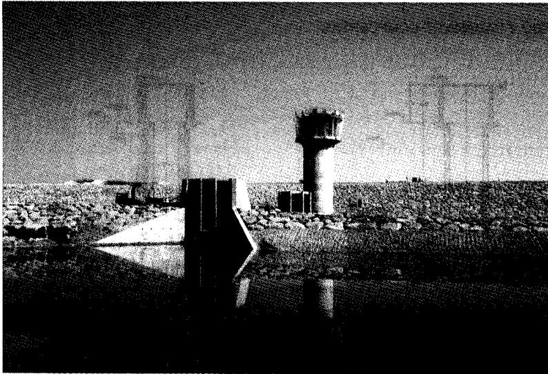
Fig. 6. De izquierda a derecha, desagüe de fondo, toma y torre de acceso.
