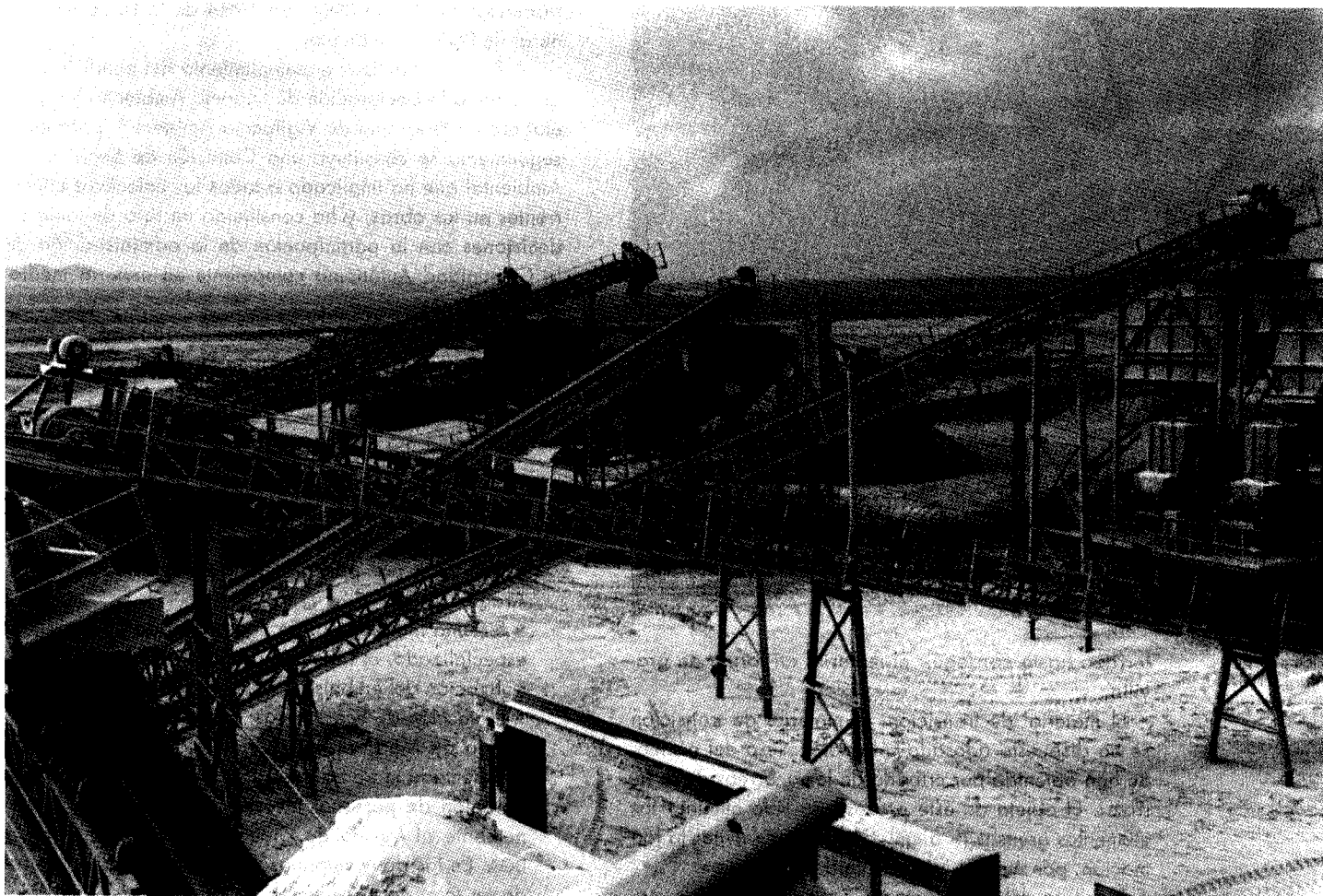
Fig. 10. Planta de machaqueo para la fabricación del filtro y el dren.
