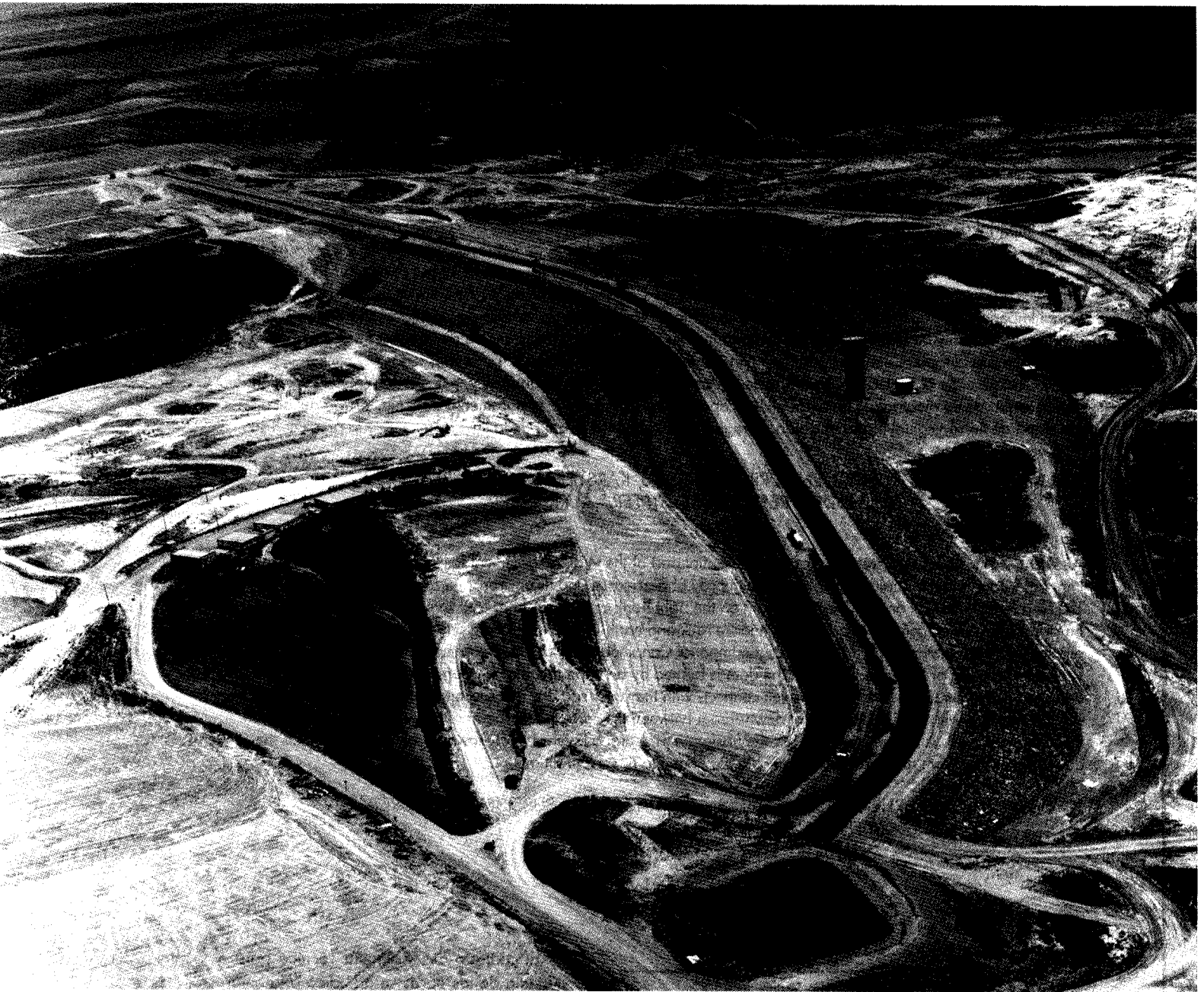
Fig. 1. Vista aérea de la presa en construcción.
