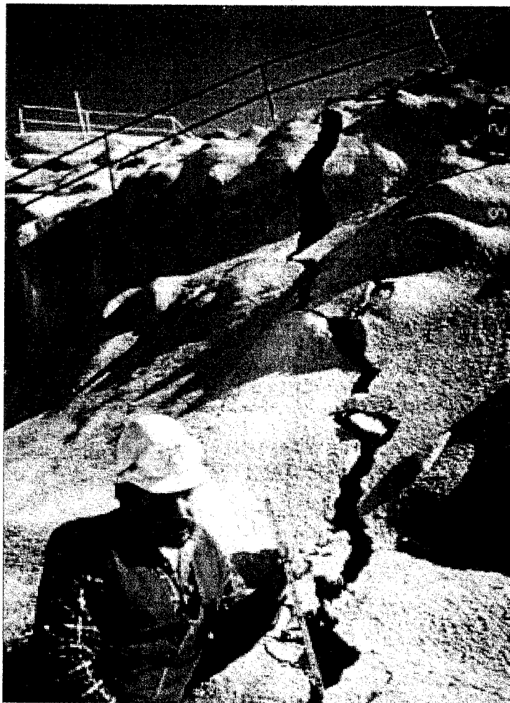
Grietas en la presa de Pacoima.
