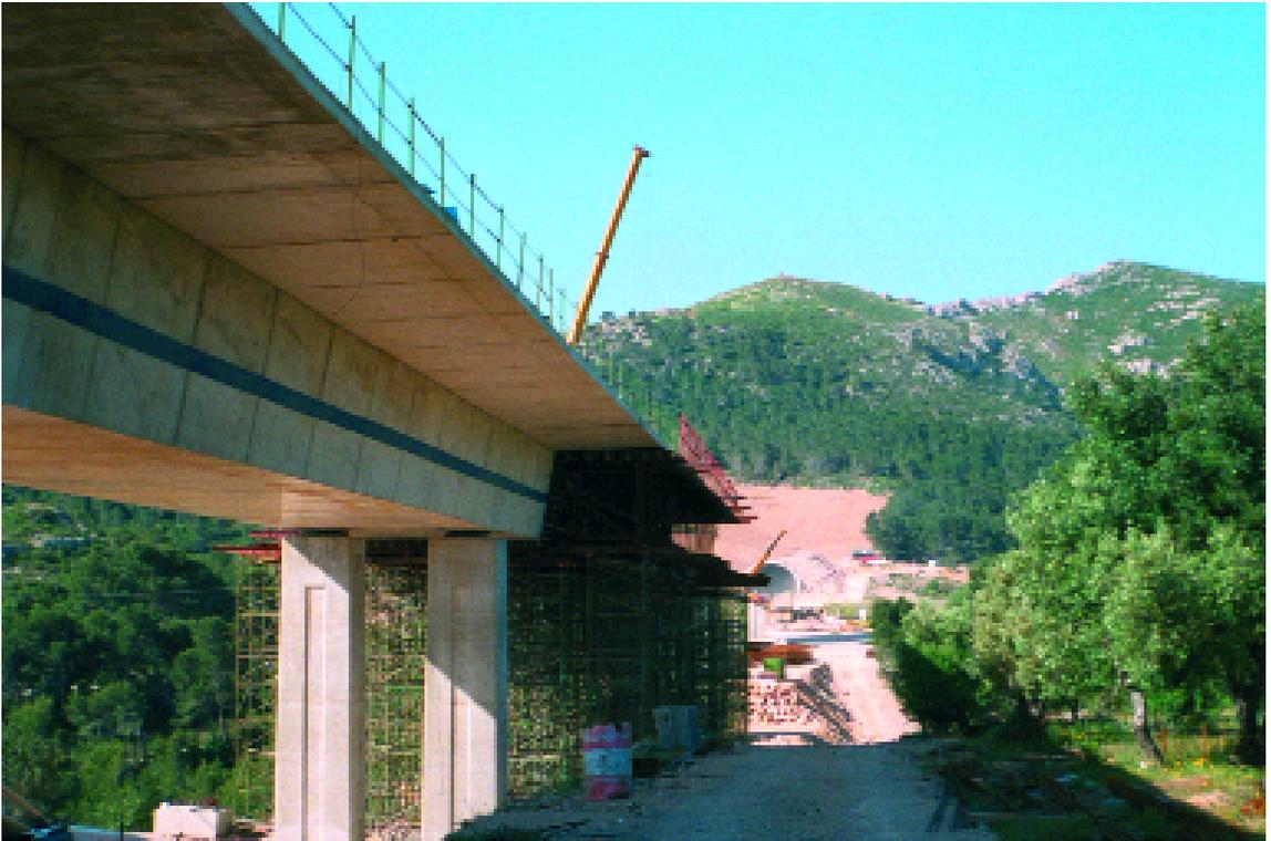
Fig. 4. Puente de la línea de Velocidad Alta Valencia-Barcelona en Vandellós. Luz máxima de 48 m, contruido vano a vano mediante cimbra convencional.
