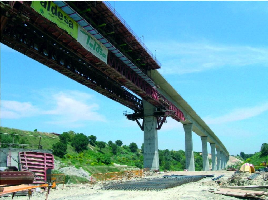
Fig. 5. Puente sobre el río Avernó en Sant Sadurní d'Anoia con vanos de 60 m de luz y una longitud total de 810 m. Construcción del tablero vano a vano mediante autocimbra.
