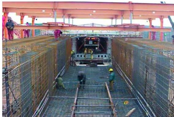
Lo habitual es que la longitud de la dovela sea del orden de la mitad de la luz de los vanos interiores. Dado que este procedimiento es adecuado para luces entre 40 y 60 m en puentes de ferrocarril, las dovelas tendrán entre 20 y 30 m de longitud. Esta longitud responde al óptimo económico de coste fijo mas coste variable para distintas longitudes de encofrado divisores de la luz.
