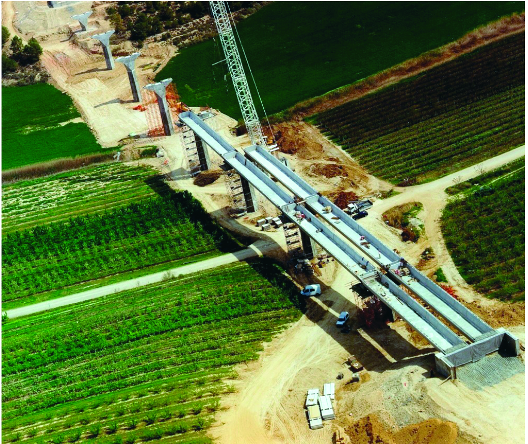
Vista general de puente de vigas prefabricadas conjuntas.
