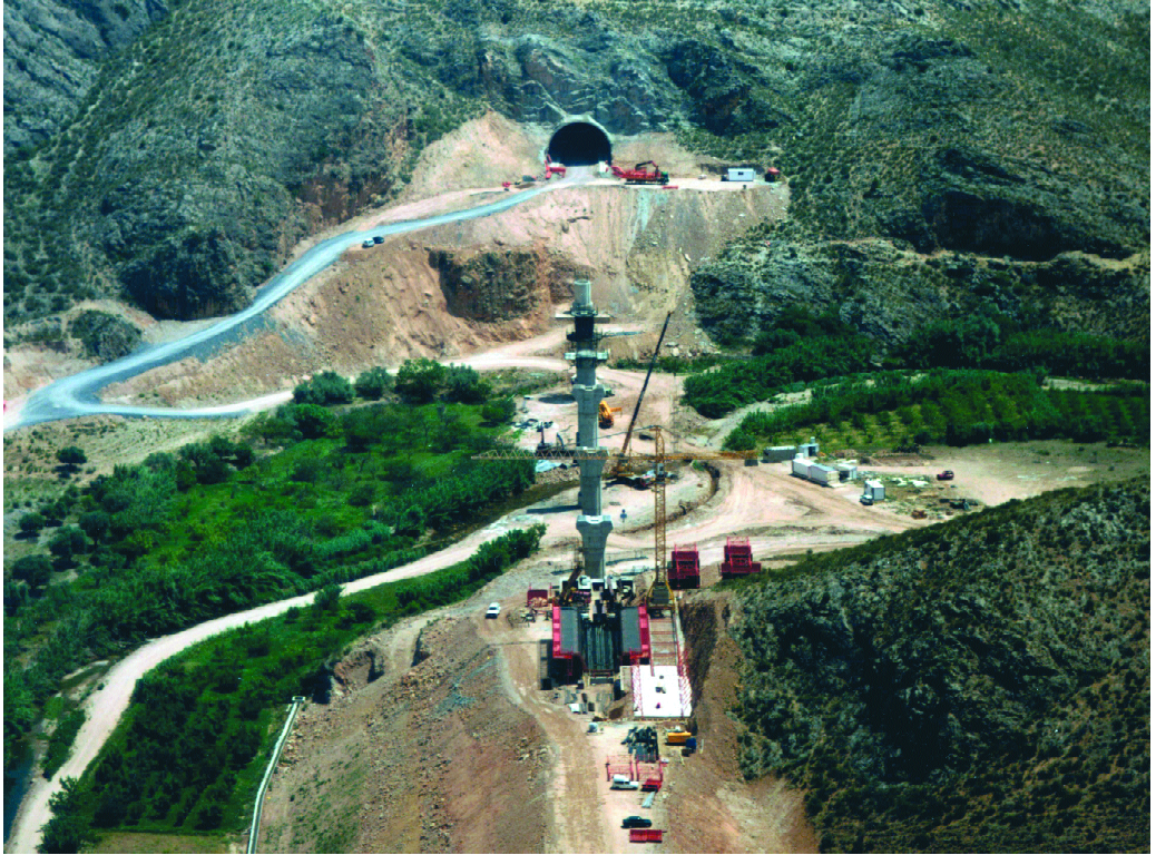
Viaducto empujado. Vista general en pilas y bancada.
