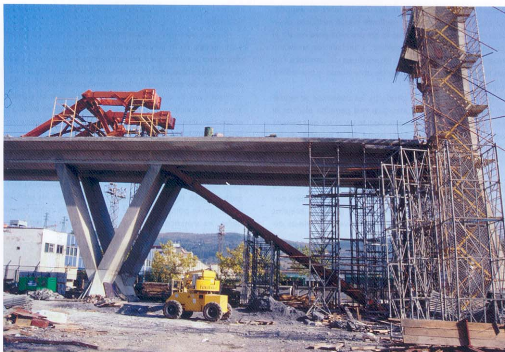
Fig. 16. Bípode de sujeción de los gatos de retenida, y las tornapuntas provisionales para referir la carga del gato a los cimientos del arco.
