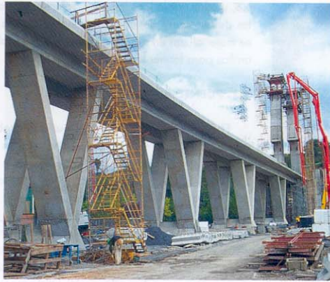
Fig. 11. Viaducto de acceso del Puente 1.
