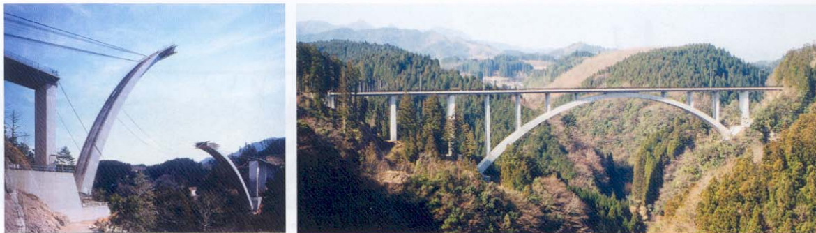
Fig. 8. Puente de Kobaru en Japón durante el montaje y terminado.
