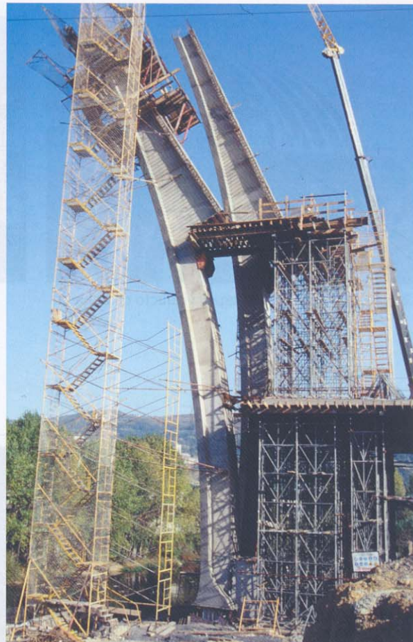
Fig. 13. Los semiarcos de margen derecha terminados. A la derecha, fig. 14. Los semiarcos de margen izquierda durante la construcción.
