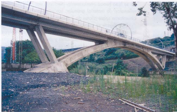
Fig. 9. El Puente 1 sobre el Nervión terminado.
