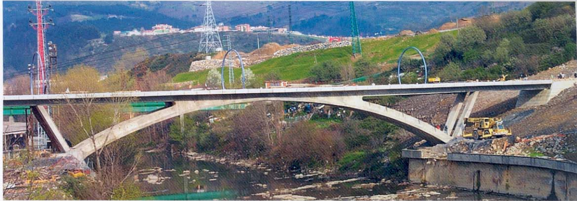
Fig. 20. El puente terminado.
