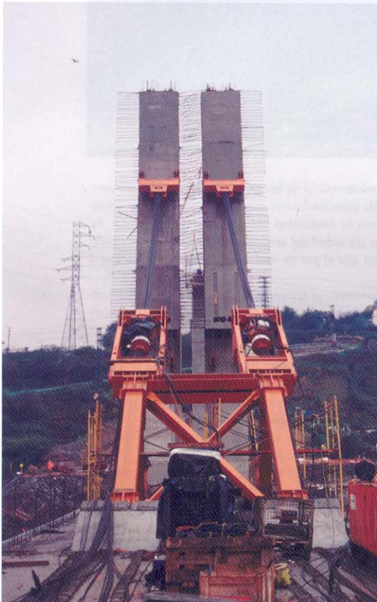
Fig. 17. Los gatos de retenida de los semiarcos. A la derecha, fig. 18. Los semiarcos durante el abatimiento.
