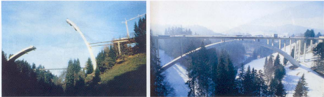
Fig. 7. Puente de Argentobel en Alemania durante el montaje y terminado.
