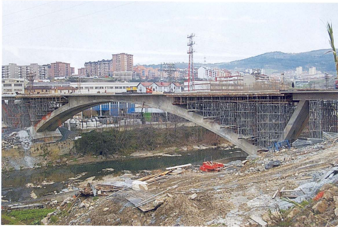
Fig. 19. Construcción del tablero sobre los arcos.
