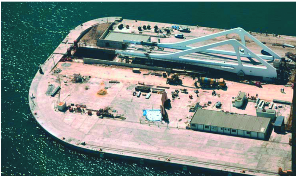
Vista de foso y tablero listo para lanzar.
