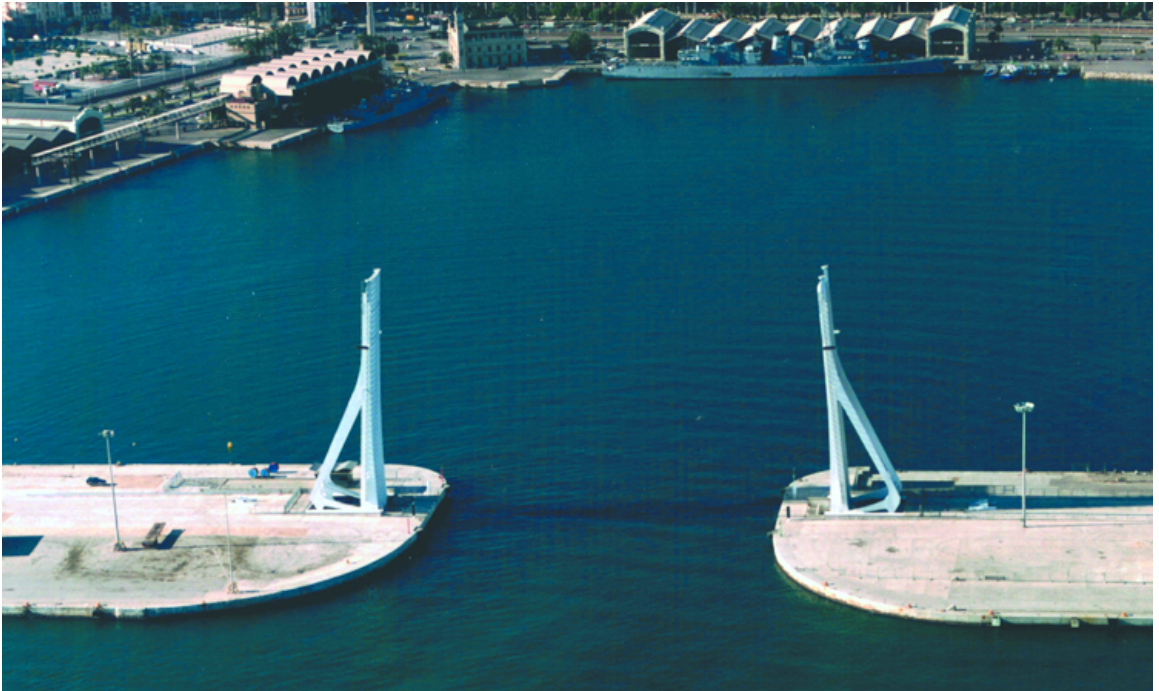
Puente terminado y abierto.
