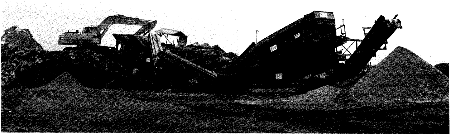
Foto 6. Instalación de machaqueo y clasificación de los productos de demolición en los accesos a la Nueva Área Terminal del Aeropuerto de Barajas.
