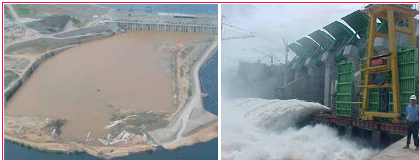
Tercera fase de construcción; inundación del canal de descarga y cierre de los conductos del desvío
