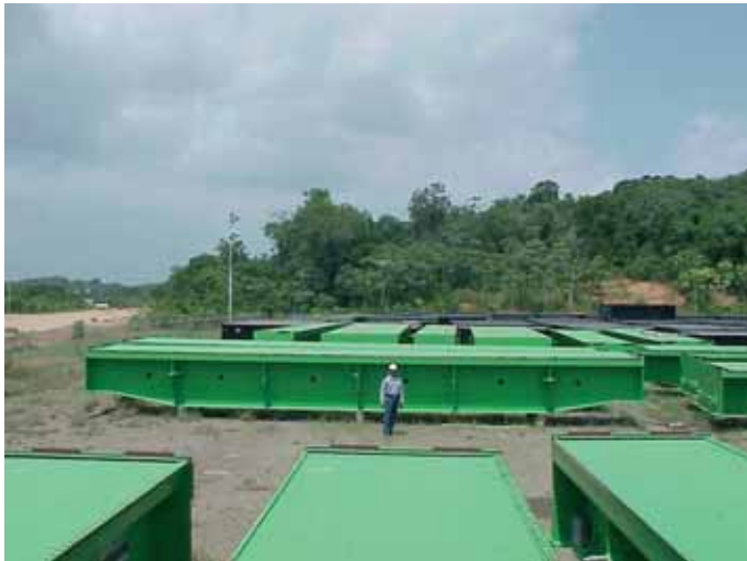
Secciones de las compuertas de mantenimiento
