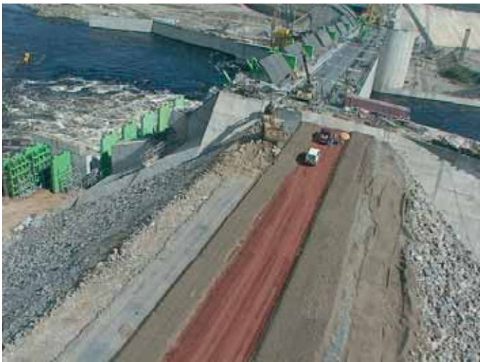
Presa margen izquierda
