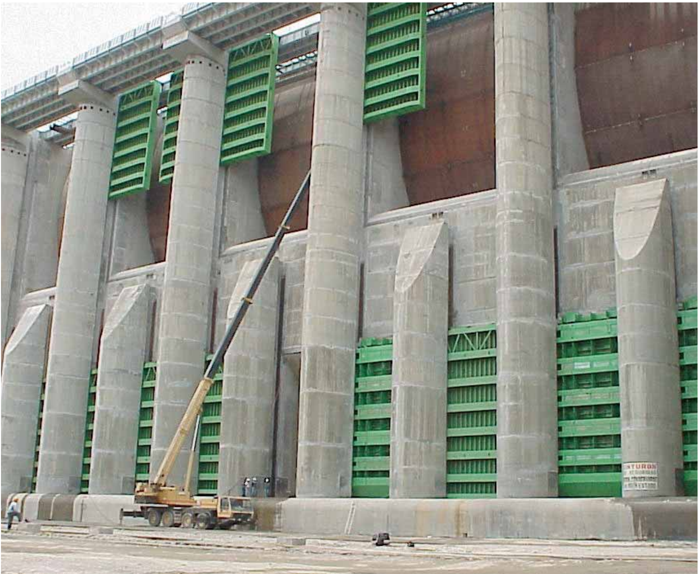
Compuertas de Emergencia del desvío
