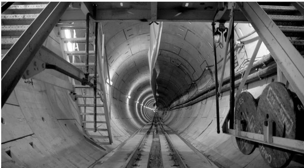
Túnel Estación Plaza de Cuba.
