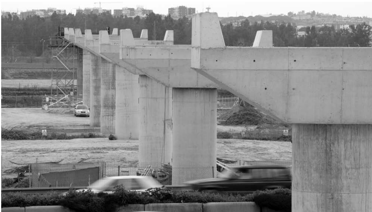
Viaducto Guadaira- Universidad Pablo de Olavide.
