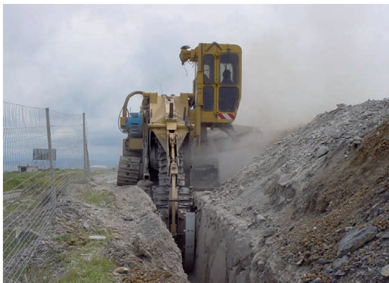
Fig. 2. En algunos de los tramos de la Autovía del agua se ha utilizado maquinaria de alto rendimiento, con el fin de acelerar la puesta en servicio de las obras.
