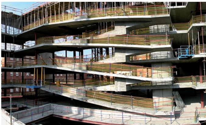
Fig. 8. Rampa volada del Centro Coreográfico y lucernario de la zona dorsal.
