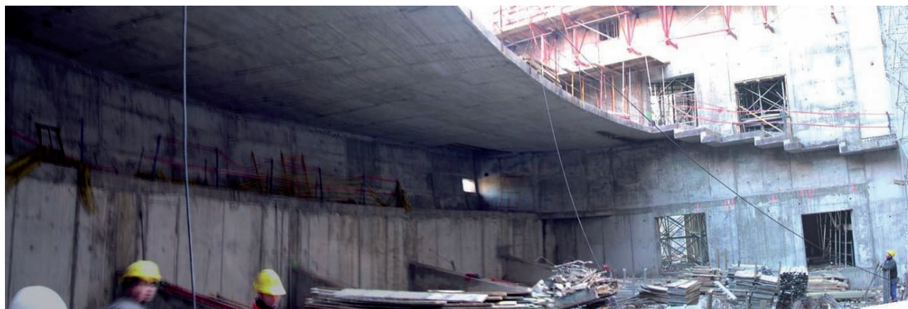
Fig. 5. Vista inferior del sistema estructural que conforma el anfiteatro.
