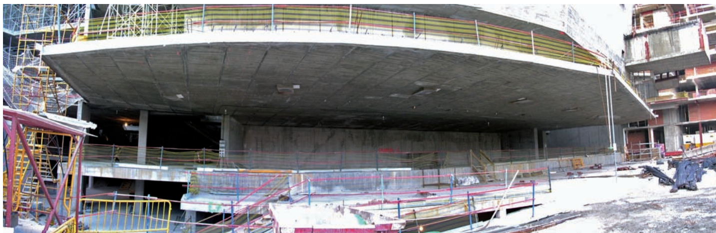
Fig. 4. Vista inferior de la gran losa volada del Teatro Principal.
