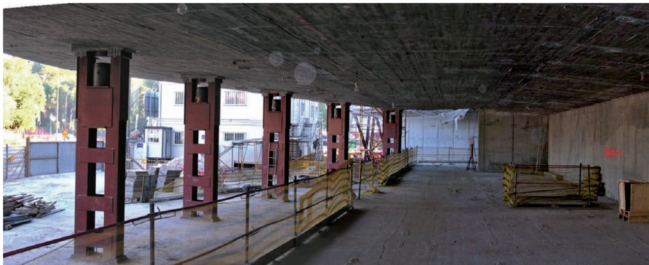
Fig. 11. Teatro Principal. Torres de apeo provisionales.
