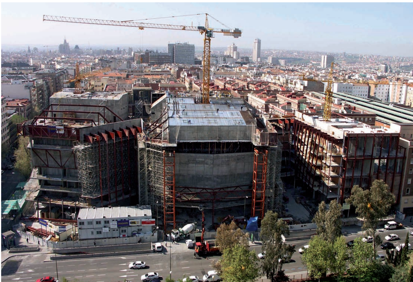
Fig. 14. Conjunto con estructura terminada.
