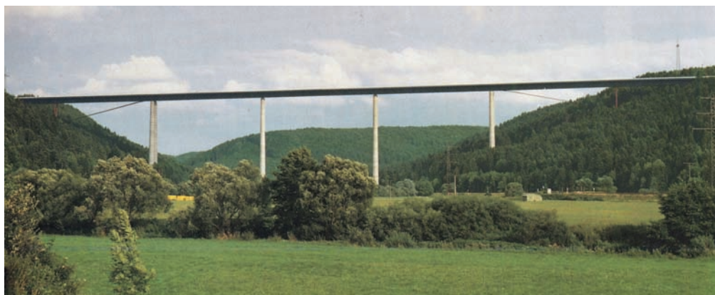
Fig. 7. Puente alto continuo. San Pablo. Londres.
