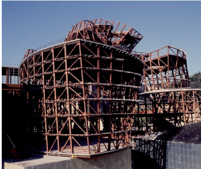
Fig. 6. Estructura metálica Guggenheim. F. Gehry.
