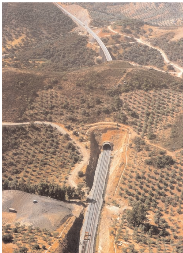
Fig. 7 A (izquierda) P.K. 309,6 Vista hacia el sur. Encima de la boquilla sur del túnel del Acebuchoso y norte del Piedras del Aire. A continuación Viaducto de La Parrilla. Al fondo boquilla norte del túnel del Cortijo (Fotos de la Ref.2).
