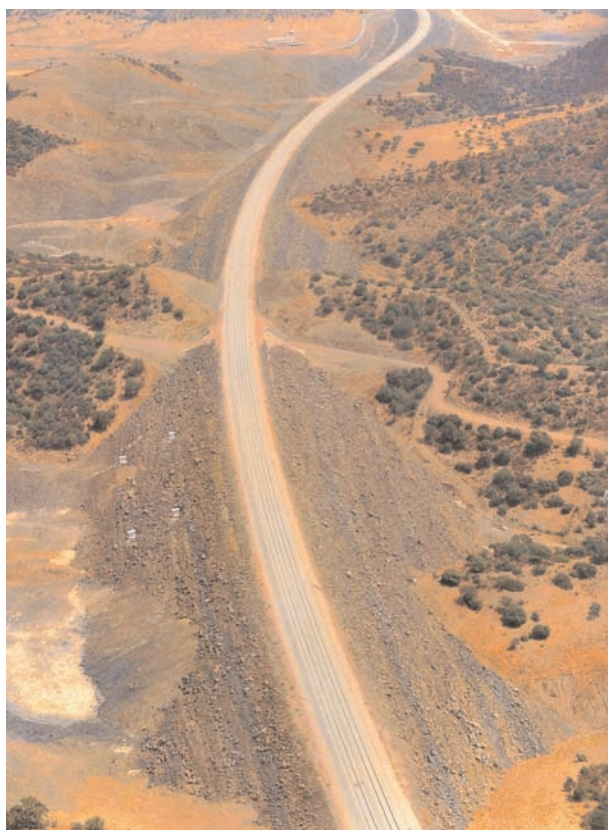
Fig. 7B (derecha) P.K. 324,1. Vista hacia el norte. Terraplenes entre los PK. 321,2 y 324,2. Al fondo boca sur del túnel Lomas del Partidor.
