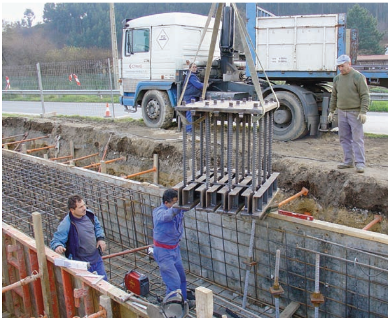
Cimentación micropilotada de la pila central y contratirante. Pieza de anclaje de la pila en cemento.
