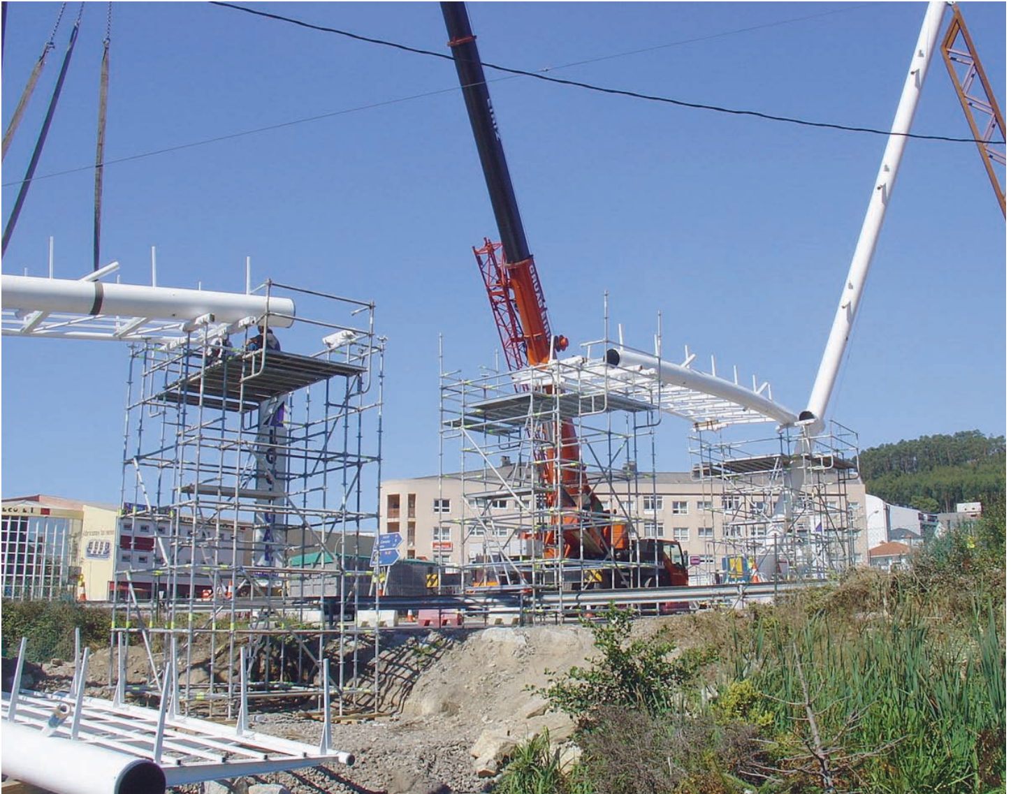
Montaje de un tramo del tablero.
