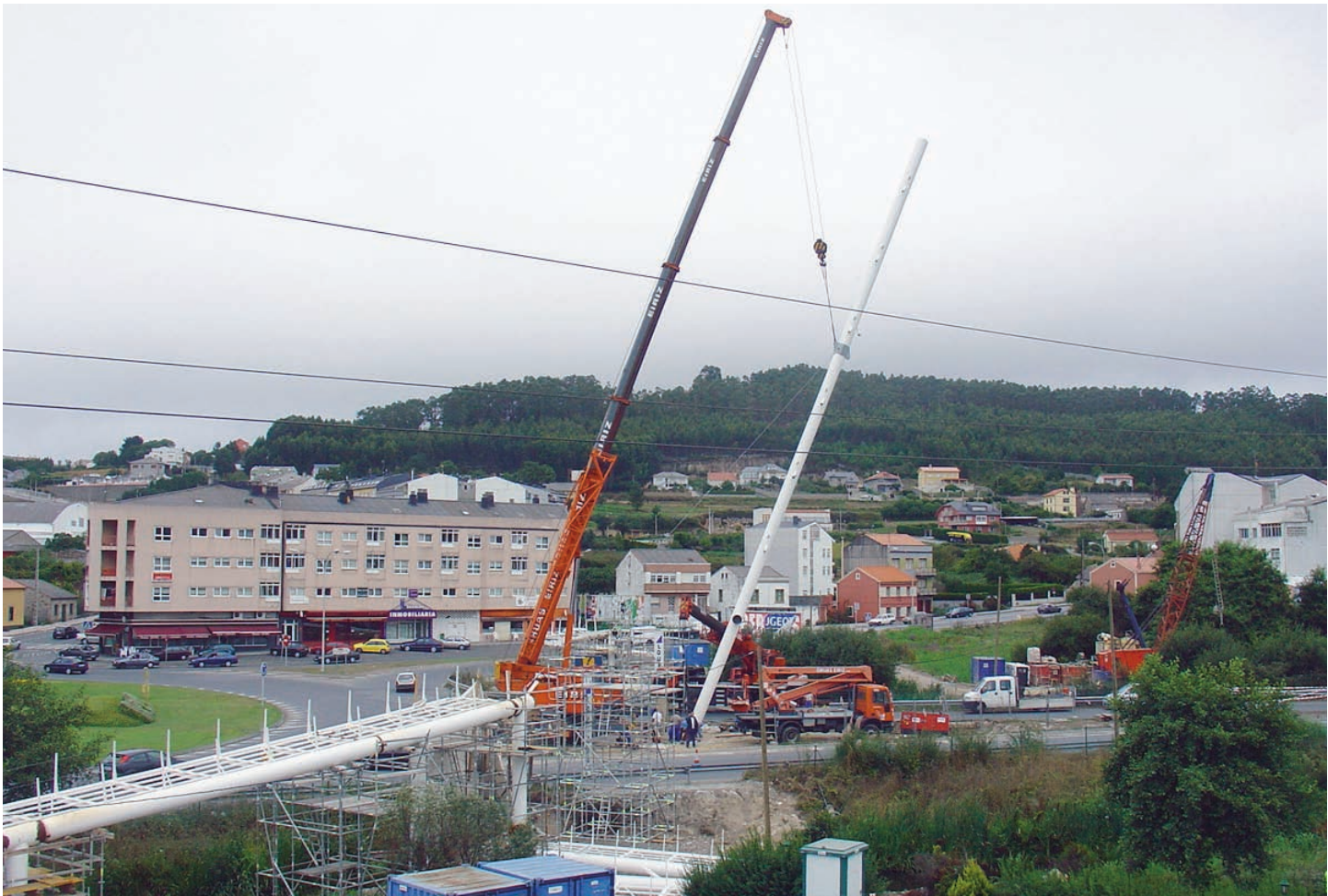
Montaje de la pila central.
