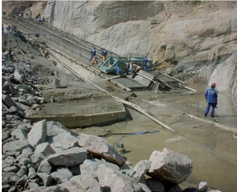
Fig. 9. Construcción del plinto en cimentación deformable. Presa de Itapebi en Brasil.
