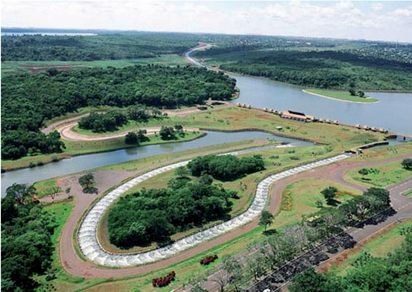
El Canal de Piracema en la presa de Itaipú (Brasil) para permitir el paso de peces tiene diez kilómetros de longitud.
