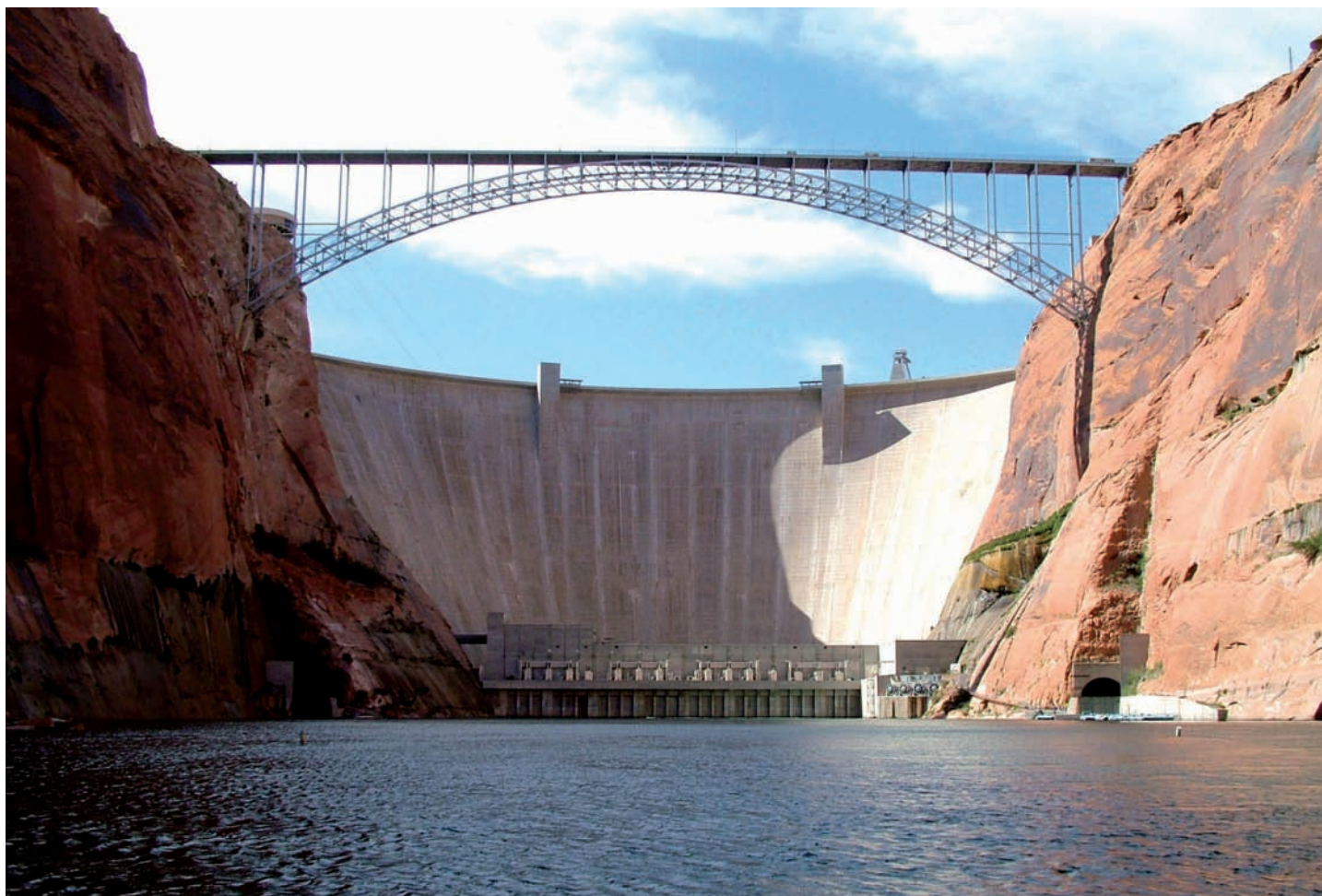
Presa Glen Canyon en el río Colorado, donde se han efectuado descargas para ayudar al mantenimiento de las barras de arena del río (Foto US Geological Survey).
