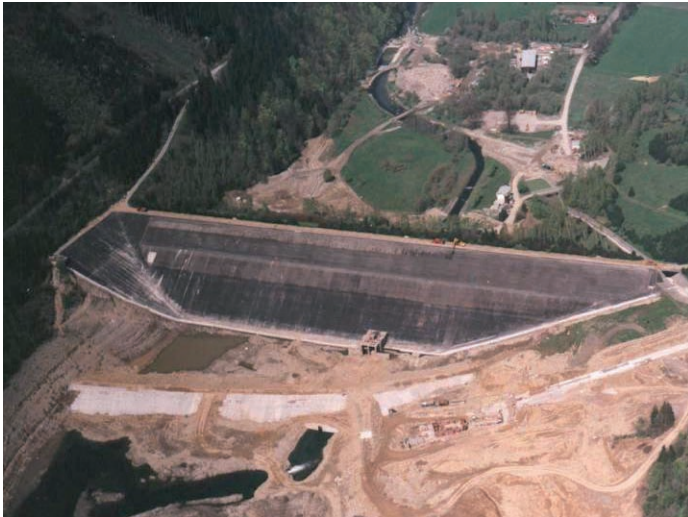
Vistas de la presa de Moravka antes y después de la reparación de su paramento de aguas arriba.
