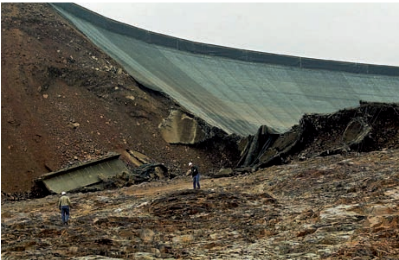
Fig. 1. Vista de la rotura del Depósito de Ameren's Sauk Tamuk (EE.UU).
