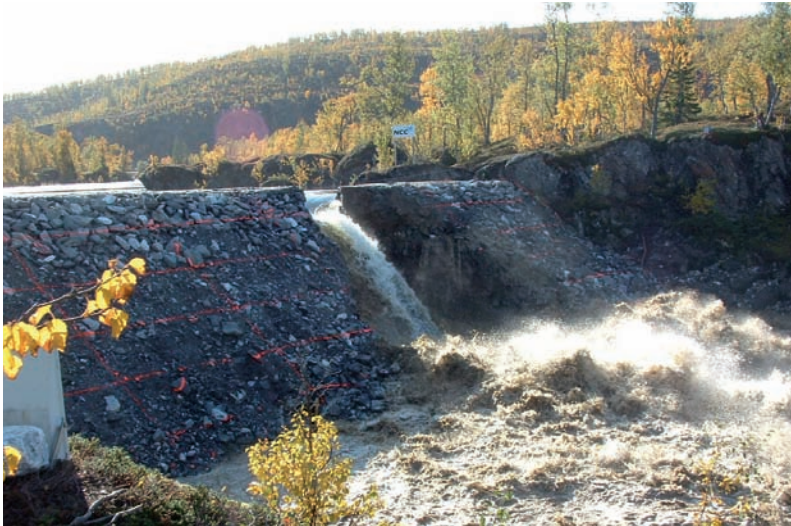
Rotura por erosión interna de un terraplén de prueba.
