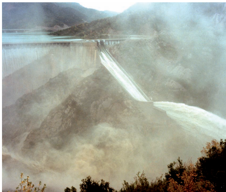
Fig.1. Laminación de avenidas. Presa de La Baells. Nov.1982.
