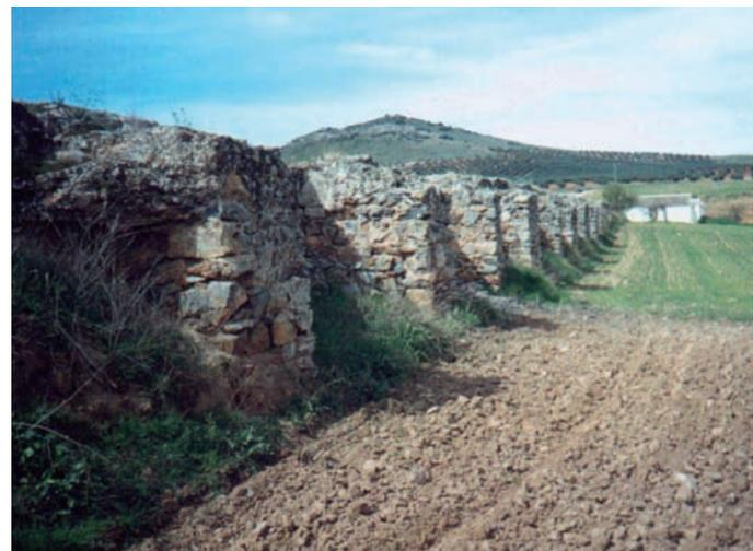
Fig. 10. Vista general de la presa de Consuegra desde la zona central aguas abajo. Detalle de los contrafuertes desde este paramento de la presa, con un remate en primer plano que denotaría un posible terraplén.
