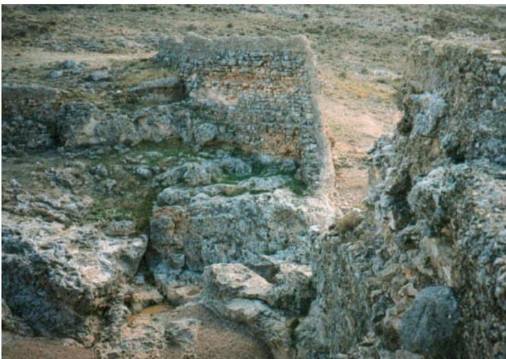
Fig. 9. Vista general de la presa de La Pared de los Moros desde el estribo izquierdo aguas abajo. Al pie, arranque de la galería de la toma de esta margen.
