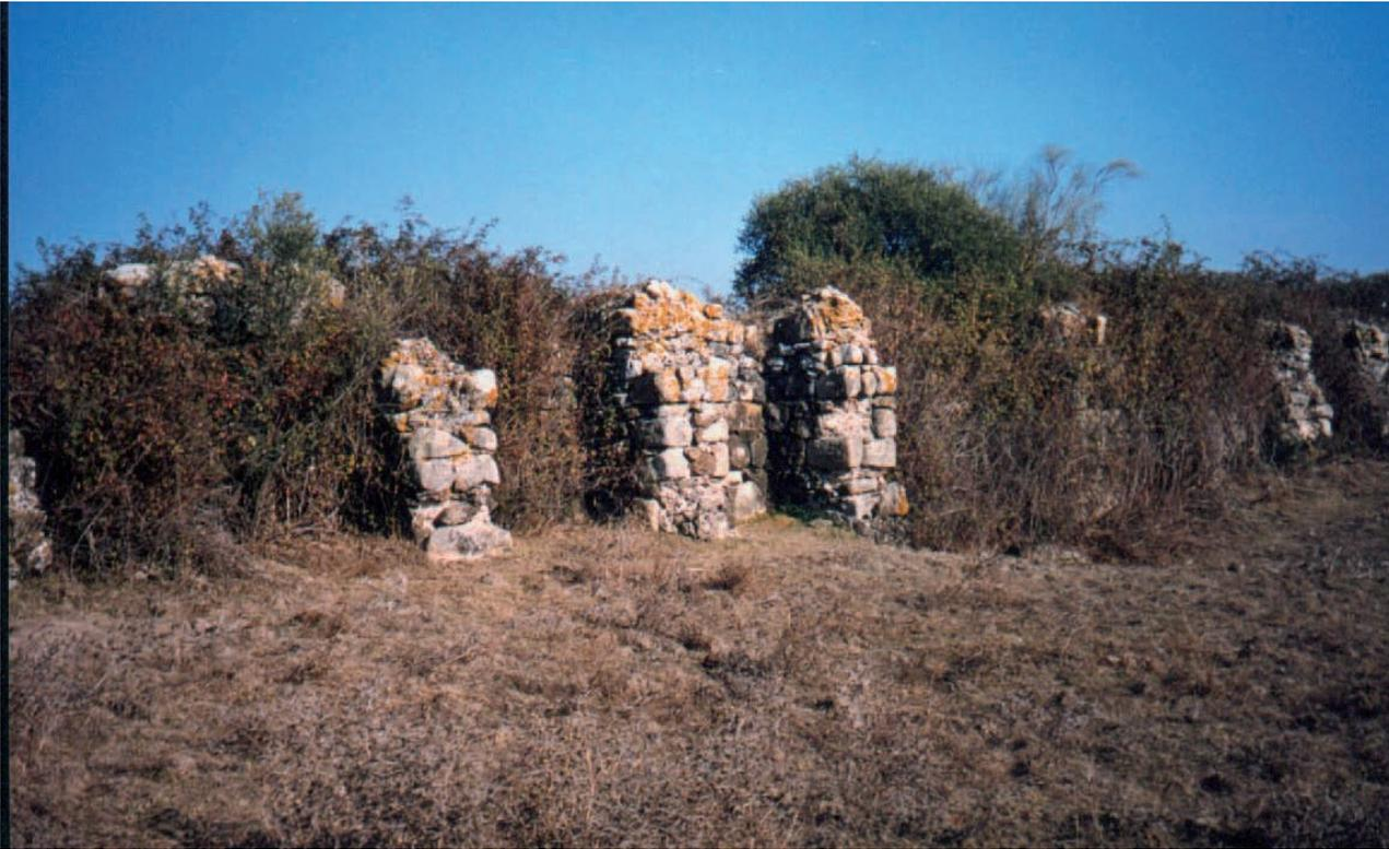
Fig. 13. Vista general desde aguas abajo de la presa de Araya, donde se aprecian los contrafuertes adosados a este paramento en la zona del desagüe.
