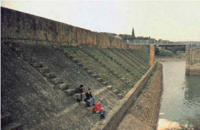
Fig. 5. Vista del paramento de aguas arriba de la presa de Cornalvo desde su estribo izquierdo, donde apreciamos el graderío entre los dos muros verticales superiores, así como el asomo de la fábrica de sillarejo entre el segundo muro y el último, sumergido bajo el embalse. A la derecha, la torre de toma exenta.
