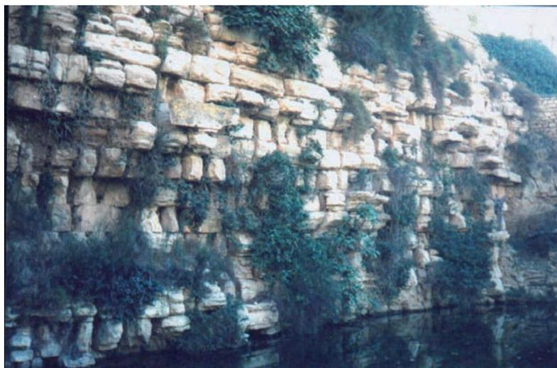
Fig. 7. Paramento de aguas abajo de la presa romana de Muel, sobre la que se levanta la iglesia de Nuestra Señora de las Fuentes (siglo XVIII). El antiguo embalse de la presa está totalmente aterrado y el río Huerva ha huido hacia un nuevo cauce. Las filtraciones a través del cuerpo de presa, probablemente a través del antiguo desagüe, se recogen en un estanque moderno adosado al paramento de aguas abajo de la presa.
