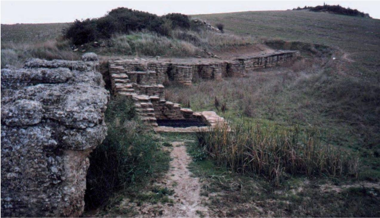
Fig 14. Vista desde coronación de la presa de Andelos o Iturranduz, donde se aprecia claramente la diferencia de aparejo entre las dos presas de Iturranduz, la del paramento de aguas abajo y del de aguas arriba. Se ve asimismo en el centro de la foto, el resto de la torre de toma correspondiente a su segunda etapa constructiva.
