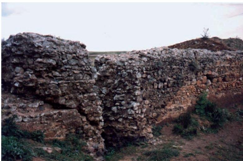
Fig. 11. Vista del paramento de aguas arriba de la presa de El Paredón, donde se aprecian la reciente rotura de la pantalla rota en su parte central, así como la huella sobre ésta de los restos del revoco de opus signinum a la derecha.
