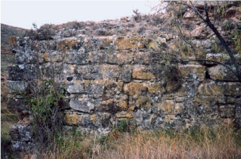
Fig. 8. Detalle del paramento de aguas abajo del estribo izquierdo de la presa de la Ermita Virgen del Pilar donde se aprecia la fábrica de sillaría del revestimiento en primer término, así como parte del opus caementicium de la pantalla impermeable sobresaliendo en la parte superior, a partir de la línea que separa las dos etapas constructivas de la presa.
