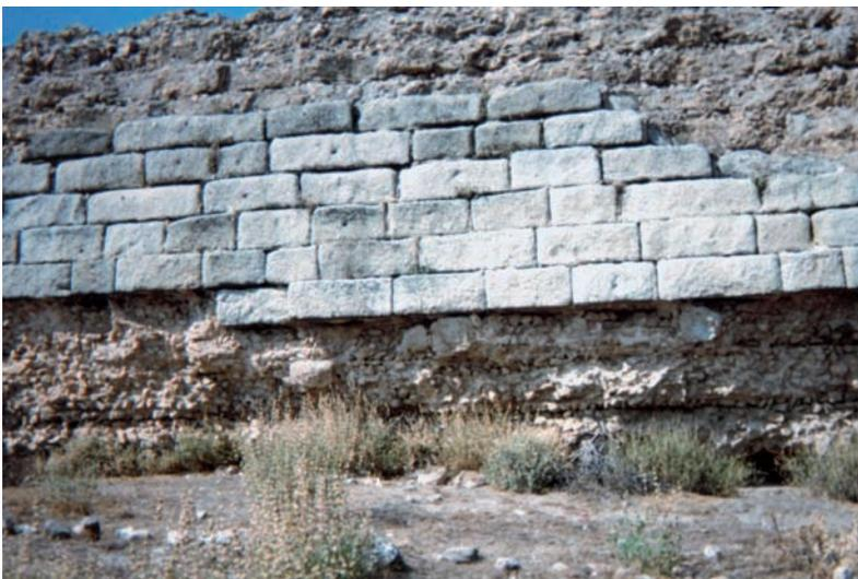
Fig. 6. Vista del paramento de la presa de Alcantarilla desde aguas arriba, donde es posible apreciar las tongadas de 0,5 m. de espesor de *opus incaerum*, así como las pocas hiladas conservadas de *opus quadratum* del revestimiento exterior.
