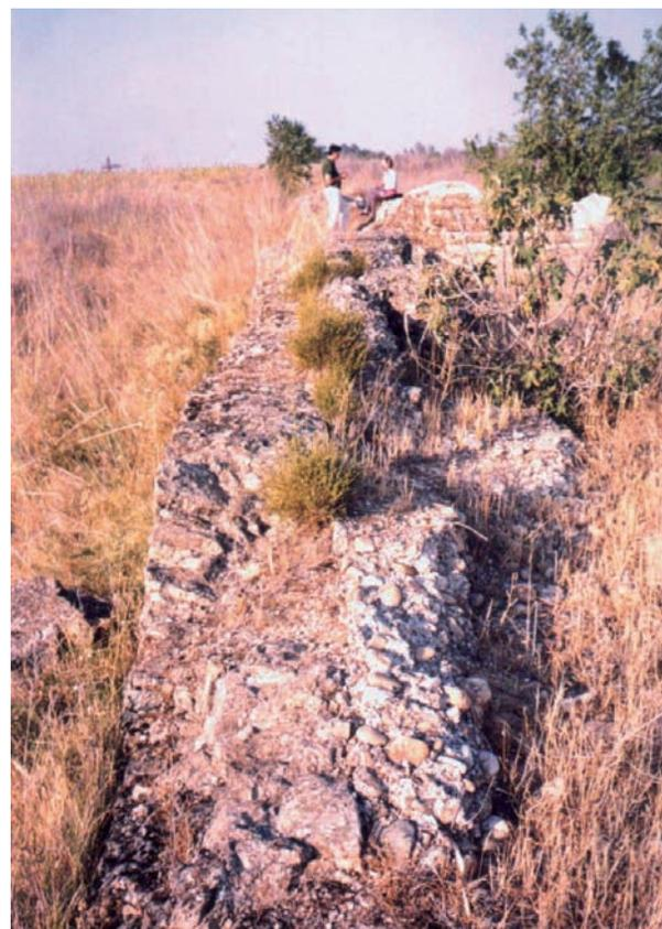
Fig. 12. Vista de la presa de Las Tomas desde la zona del estribo izquierdo, con detalle de su pantalla.
