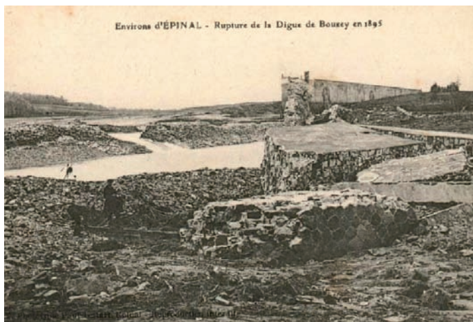
Fotografía Nº 4.- Vista de la presa de Bouzey, poco después de su rotura (1895).
