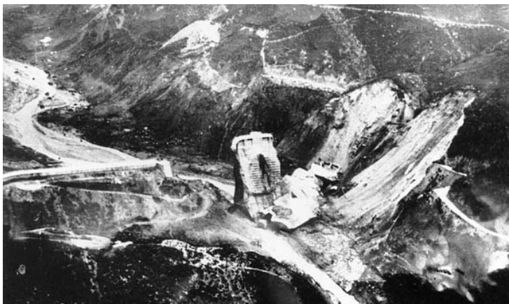
Fotografía Nº 6.- Vista de la presa de St Francis, tras la catástrofe del 12-Marzo-1929.
