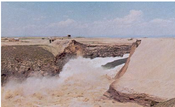
Fotografía Nº 8.- Rotura de la presa de Teton, al mediodía del 5-Junio-1976.
