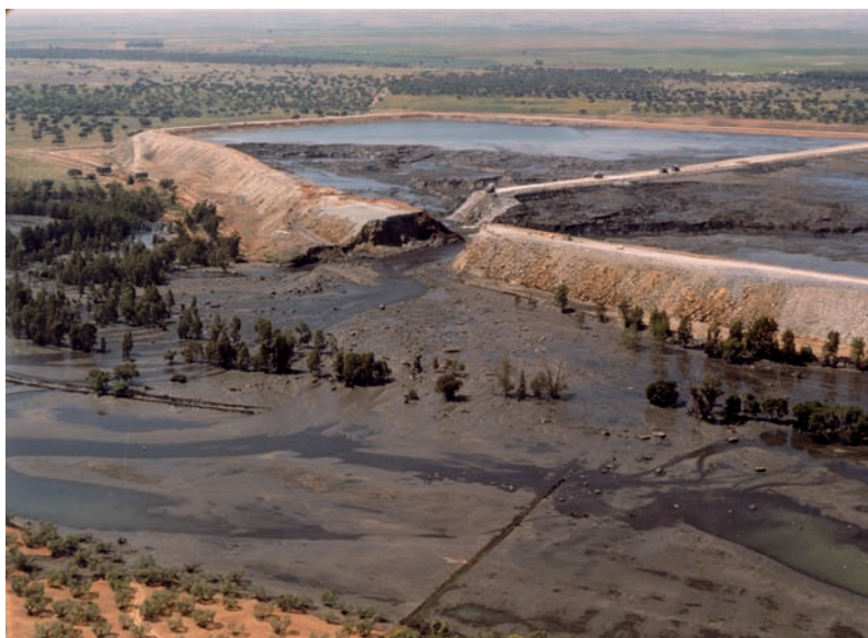
Fotografía Nº 10.- La balsa de "Los Frailes" (o presa de Aznaicóllar), tras su rotura el 24-Abril-1998.
