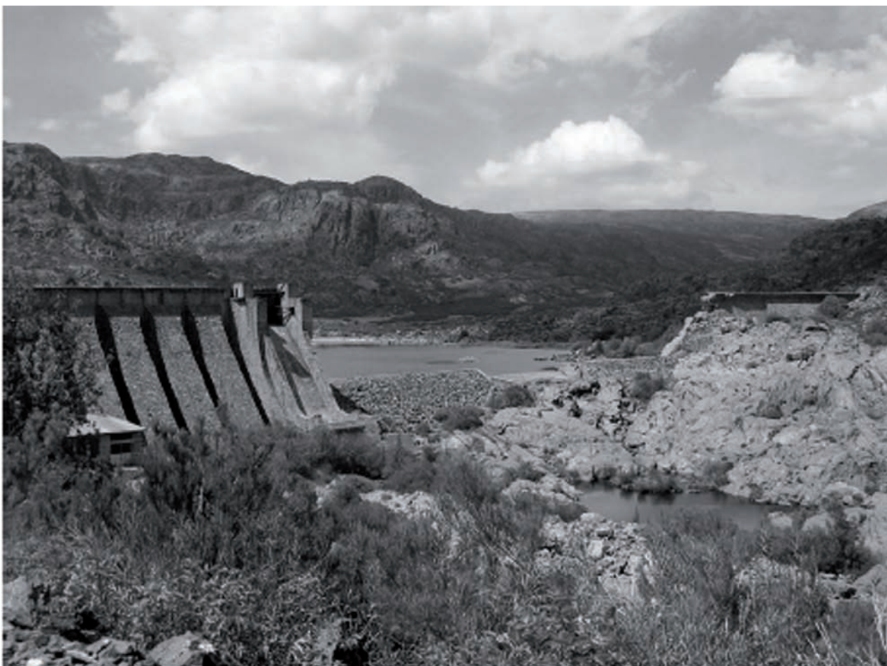
Fotografía 1. Presa de Vega de Tera o Ribadelago tras la rotura.
