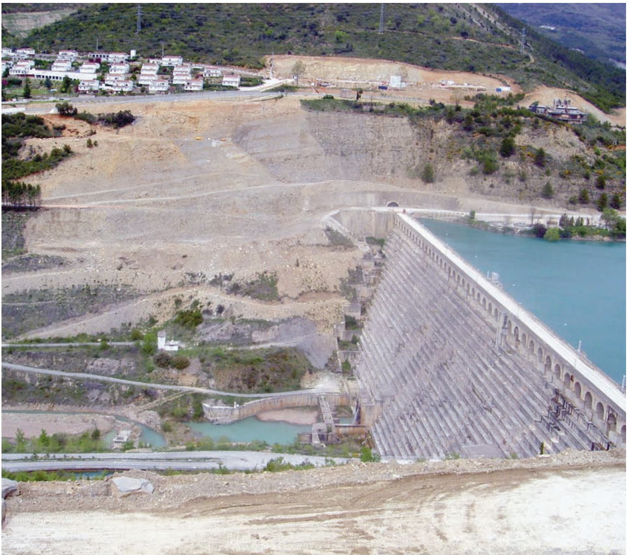
Fig. 6. Desmante antiguo y nuevas excavaciones en el estribo derecho.
