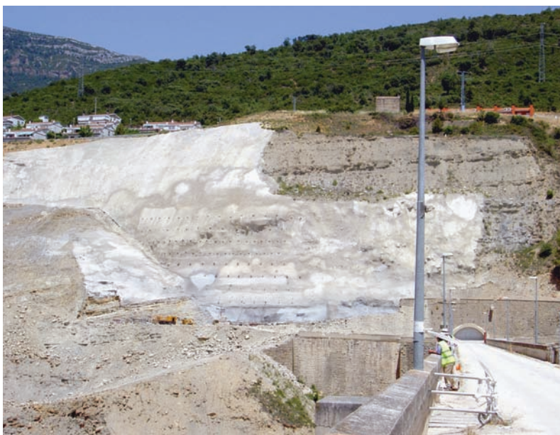
Fig. 15. Estabilización de las excavaciones del estribo derecho con bulones y anclajes.
