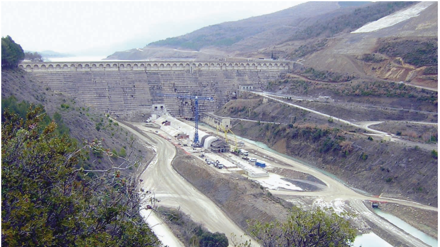
Fig. 17. Construcción del desagüe de fondo.
