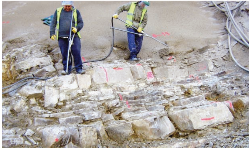
Fig. 10. Cimentación del plinto sobre roca alterada en el estribo derecho.
