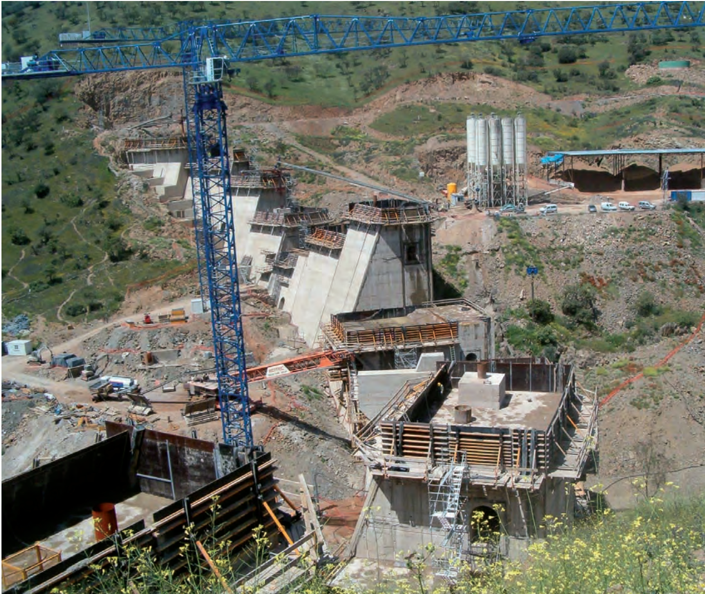
Fig. 11. Vista de la planta de hormigonado y sistema de cintas para puesta en obra del hormigón.
