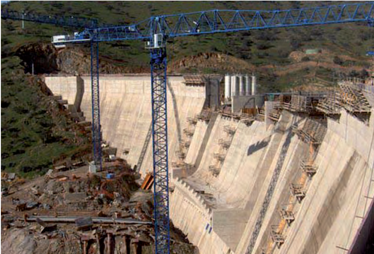
Fig. 4. Fotografía de la presa durante su construcción.
