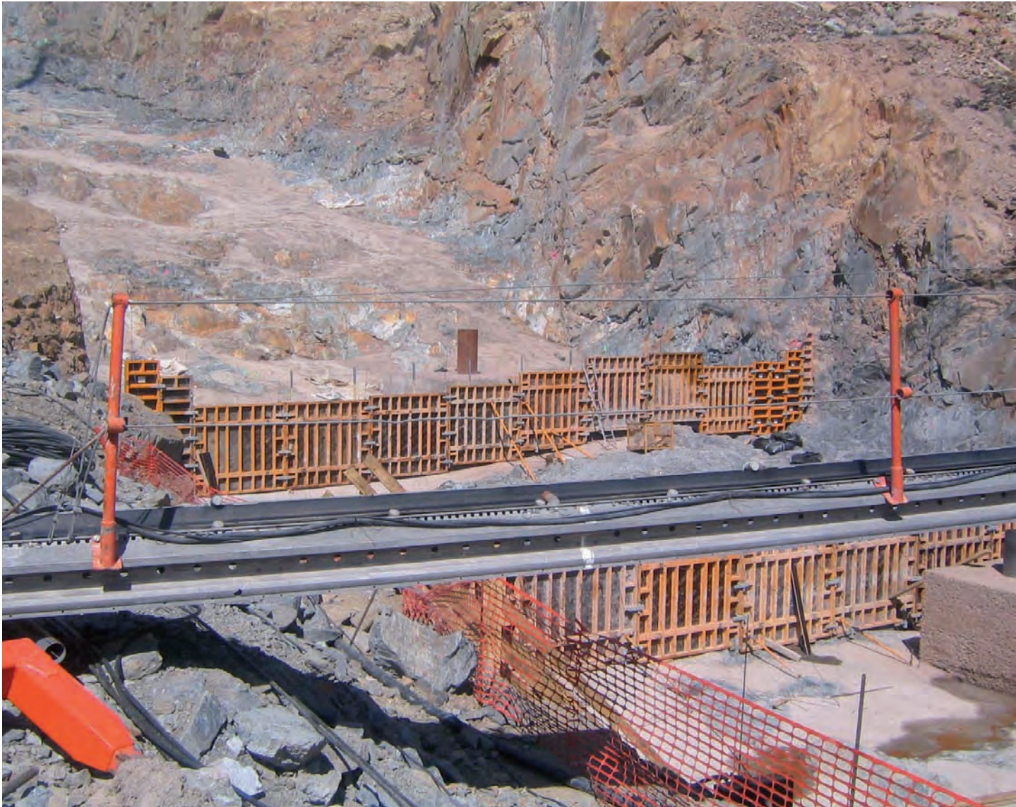
Fig. 7. Detalle de cimentación de la presa con hormigón de regularización . Cintas transportadores de puesta en obra del hormigón.
