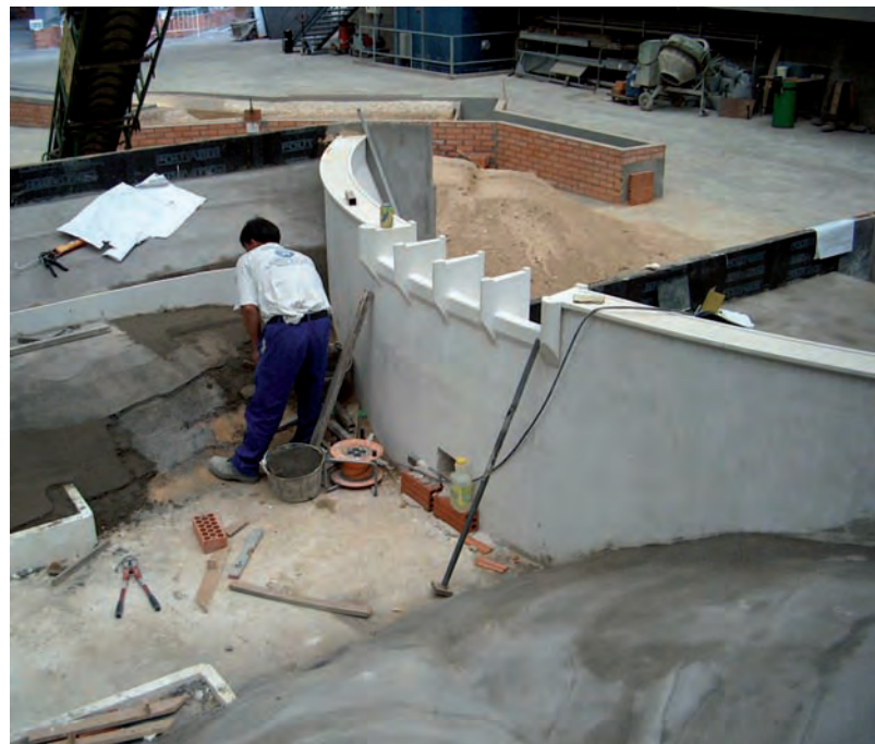
Fig. 8. Modelo reducido en construcción realizado por el Centro de Estudios Hidrográficos.
