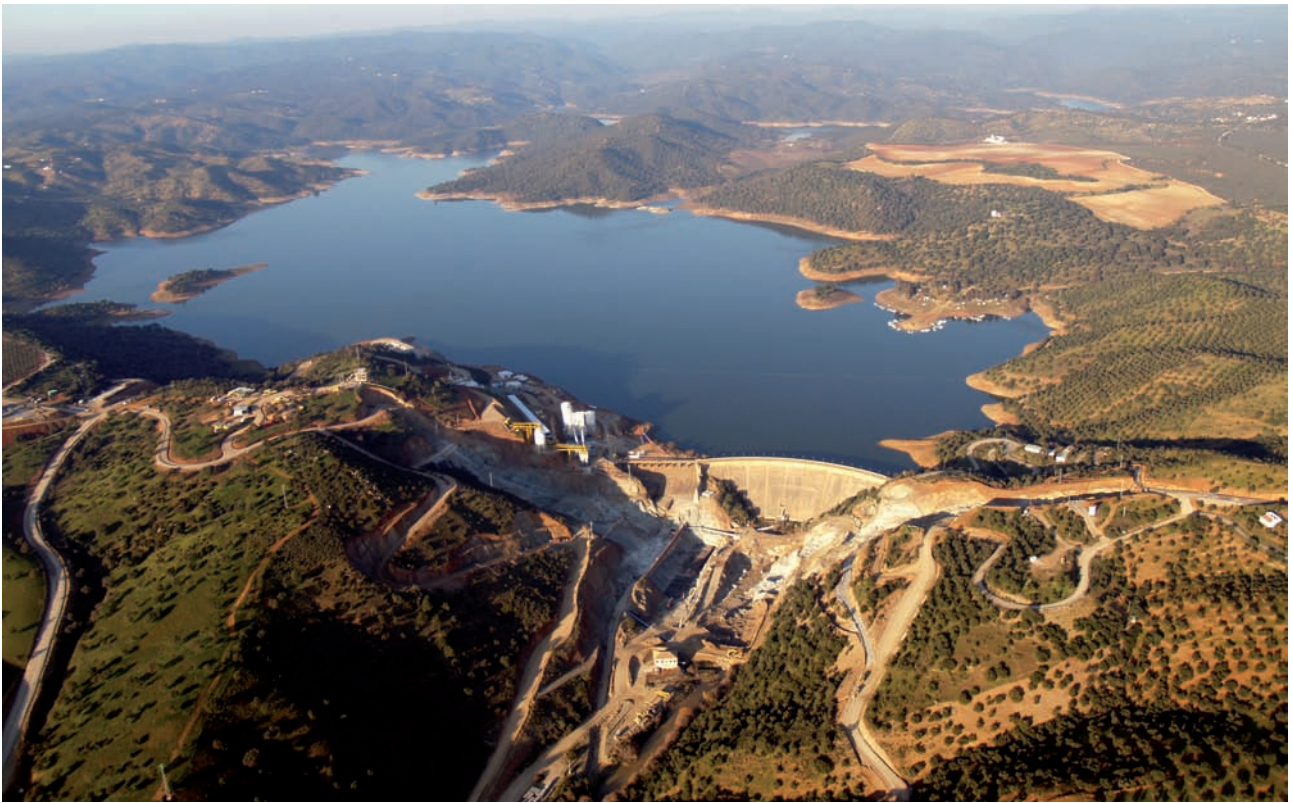
Presas actual de Breña en el río Guadiato.
