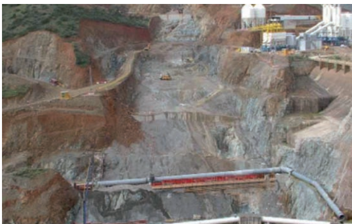
Excavación de la cimentación y acceso a galería.
