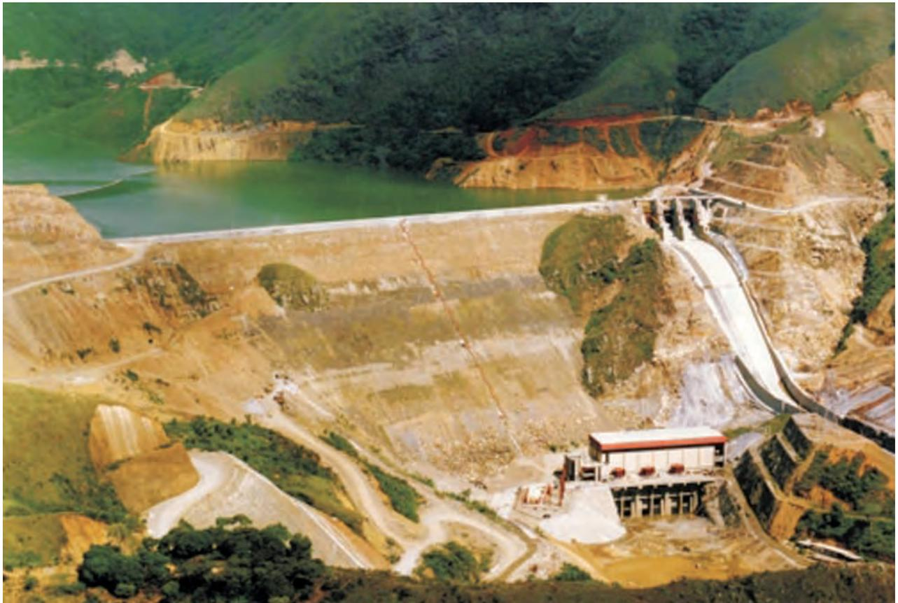
Las mediciones de obra civil más significativas fueron: Hormigón refrigerado (por debajo de 12°C) 1.830.000 m<sup>3</sup>. Acero de armar 90.165.000 kg. Encofrados 680.000 m<sup>2</sup>. Acero para conductos y embebidos 5.400.000 kg.
