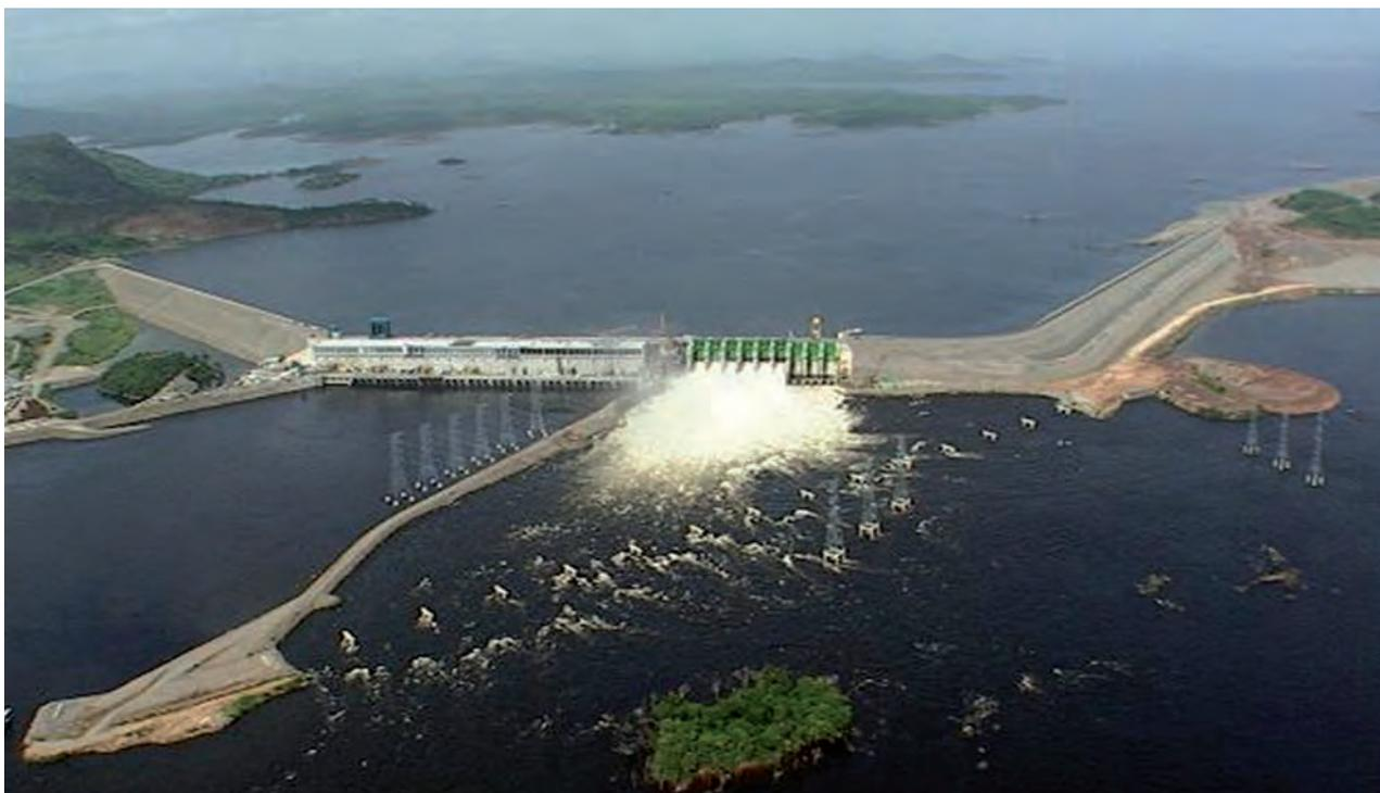
para alcanzar una capacidad de 13.230 m<sup>3</sup>/s para el máximo nivel del embalse.
