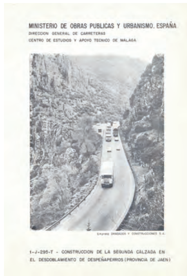
Fig. 5. El pavimento de hormigón para la duplicación del paso de Despeñaperros.
