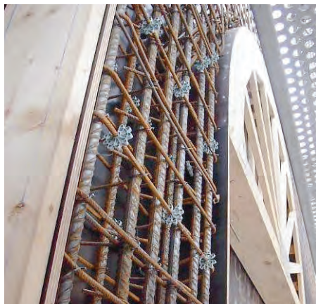
Detalle de encofrado y ferrallado de la camisa de claustro.
