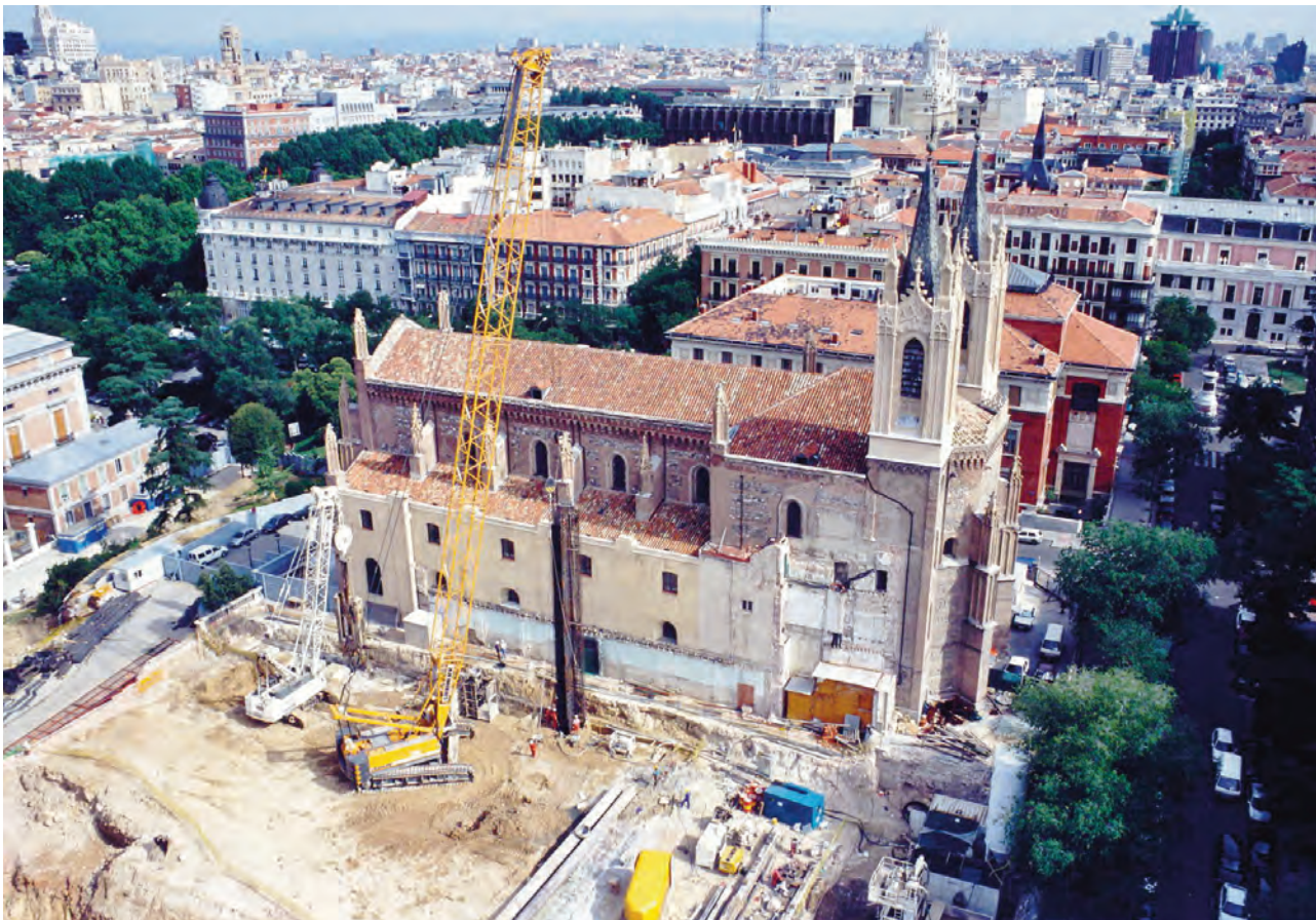
Colocación de jaulas de armadura en la pantalla contigua a los Jerónimos.
