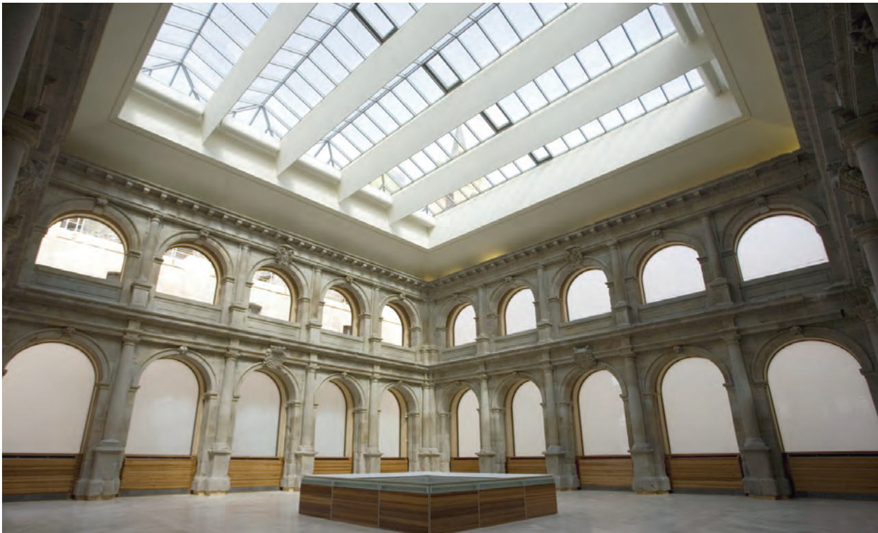
Vista del interior del claustro terminado, con el lucernario de cubierta.
