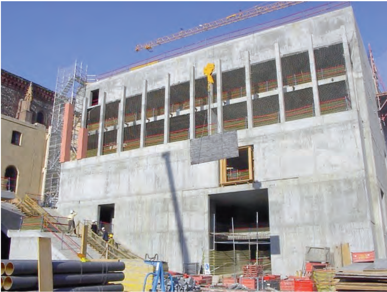
Estructura sobre rasante.
