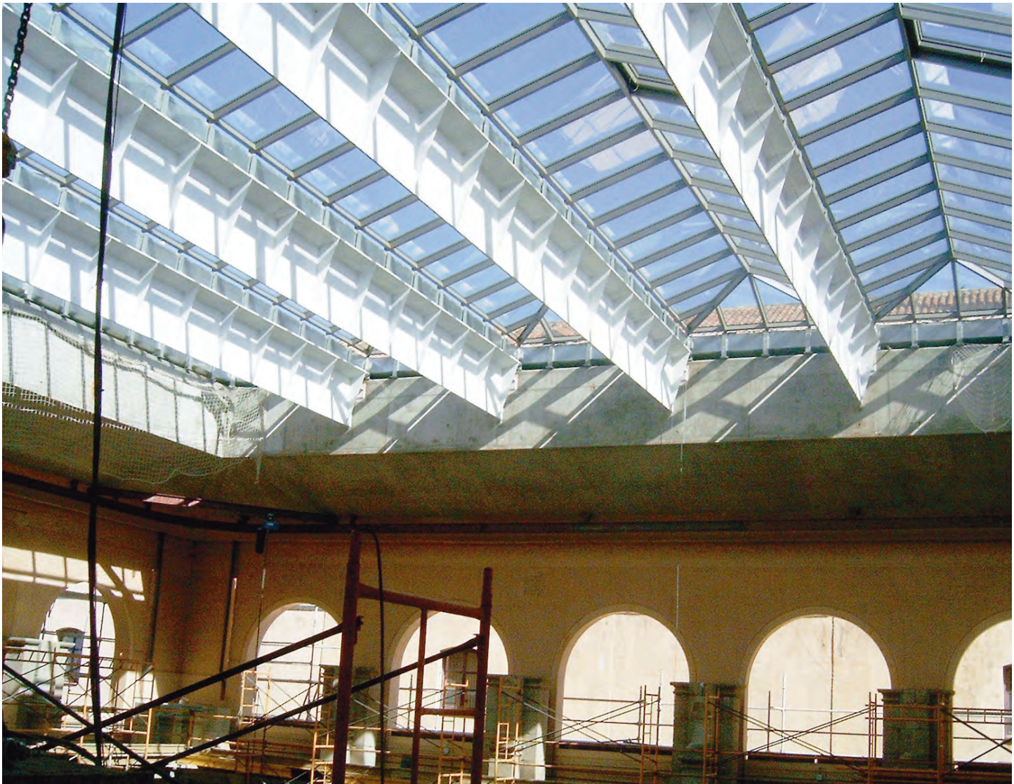
Lucernario de la cubierta del claustro.
