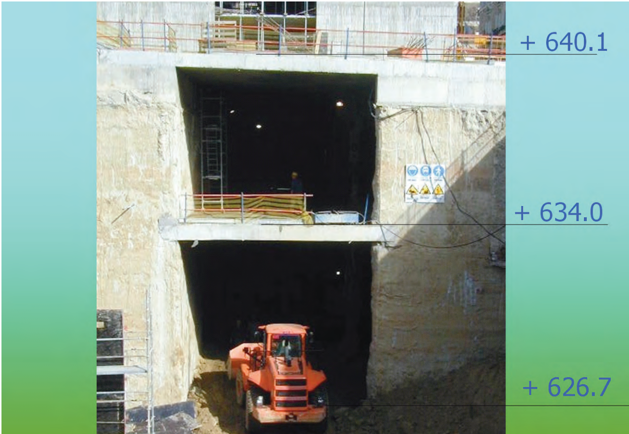
Excavación en mina bajo la losa de cota 634.
