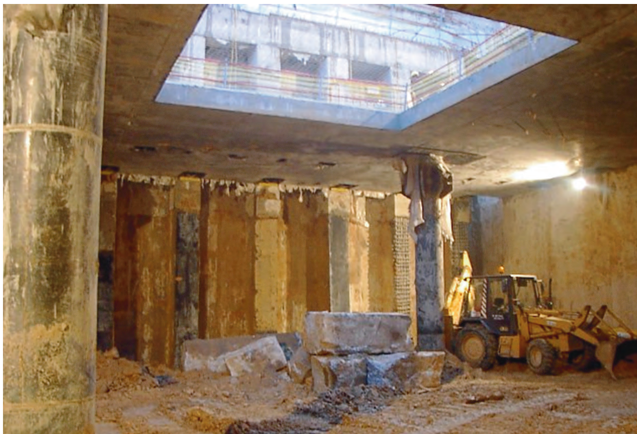
Excavación en mina bajo la losa de cota 640.
