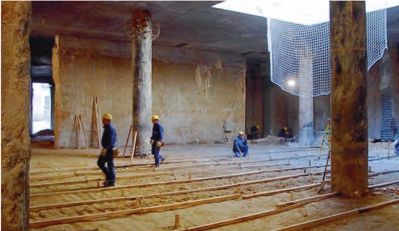
Colocación de rastreles para hormigonado de losa de cota 634.
